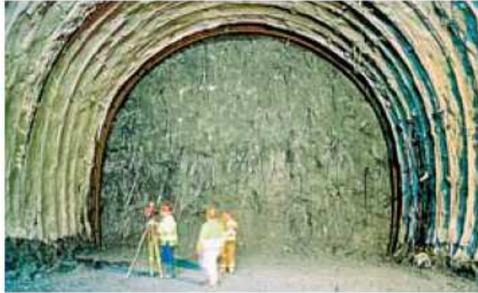
图片5: Pianoro 隧道（意大利博洛尼亚至佛罗伦萨高速铁路，岩层：胶结泥砂土，覆盖层：150 米，隧道直径：13.30米）。采用玻璃纤维构件加固开挖面。
