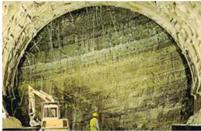
图片4: Tartaignille 隧道 (法国马赛至里昂高速铁路 Mediterranee, 岩层: 膨胀性粘土 (75%的高岭石), 覆盖层: 100米, 隧道直径: 15 米)。采用玻璃纤维构件加固开挖面 (180m 2 )。
