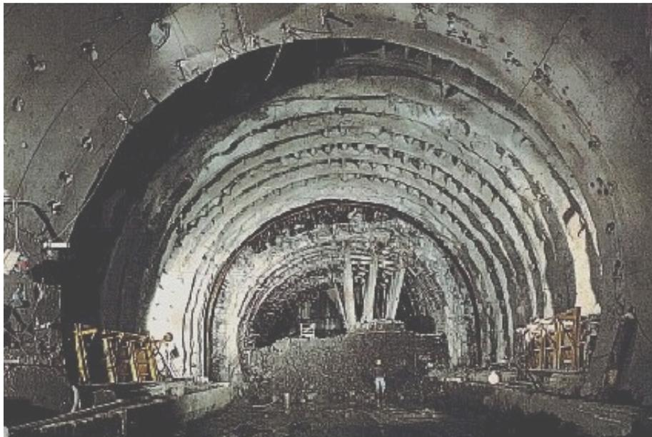
**Foto 1.** Túnel de Stefano (Italia, línea de ferrocarril Génova-Ventimiglia; terreno: calizo-margoso tectonizado y laminado, recubrimiento: 150 m, diámetro de túnel: 12 m). Colapso de la cavidad.
