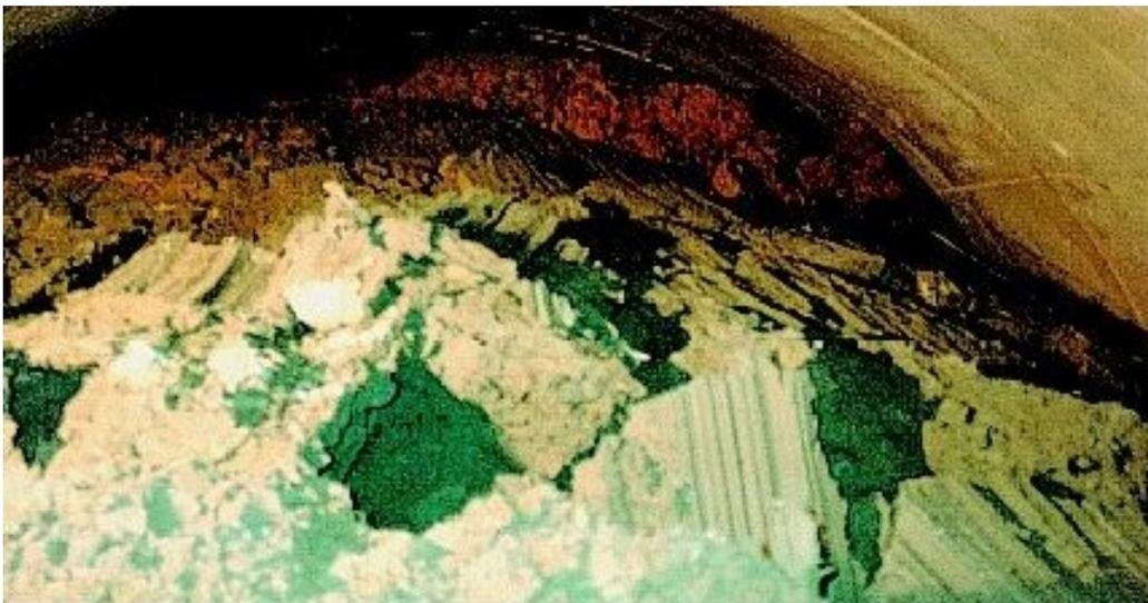
**Foto 2.** Túnel de Vasto (Italia, línea de ferrocarril Ancona-Bari; terreno: arcilla limosa, recubrimiento: 135 m, diámetro del túnel: 12,20 m). La extrusión del terreno a través del frente durante el avance y la destroza (según los principios del NATM).
