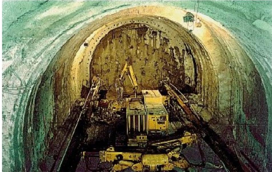
Foto 3. El túnel de Vasto: refuerzo de la zona de avance con tubos de fibra de vidrio durante la excavación a sección completa (de acuerdo con los principios A.DE.CO.-RS).
