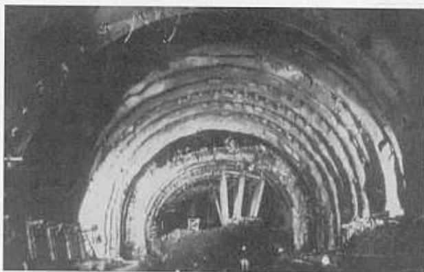
Foto 1 - Túnel S. Stefano: Colapso da cavidade
