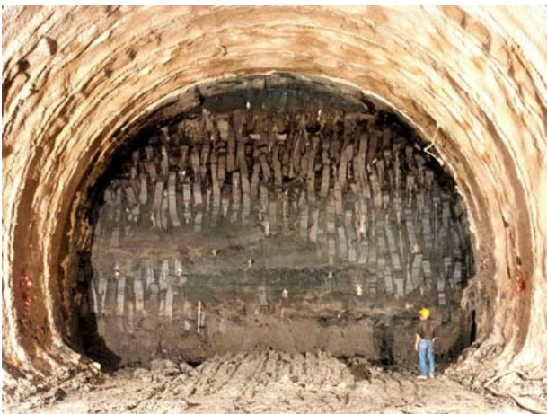
Foto. 3: Galleria Tasso (linea ferroviaria A.V. tra Firenze e Arezzo): vista del fronte durante lo scavo a piena sezione, nelle stesse condizioni tenso-deformative delle foto 1 e 2, previo consolidamento del nucleo d'avanzamento con chiodi tubolari di vetroresina (approccio A.DE.CO.-RS). Adottando una corretta progettazione dello scavo si ottenne una produzione regolare media di circa 2 m/g.
