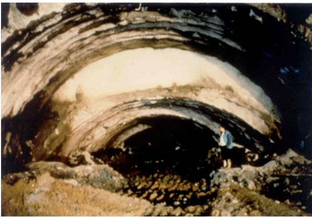
Foto. 2: Galleria Tasso (linea ferroviaria A.V. tra Firenze e Arezzo): collasso della cavità a seguito del crollo del fronte avvenuto durante lo scavo a mezza sezione.
