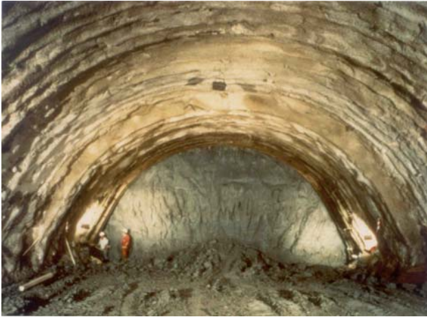
Foto. 1: Galleria Tasso (linea ferroviaria A.V. tra Firenze e Arezzo): vista del fronte durante lo scavo a mezza sezione.
