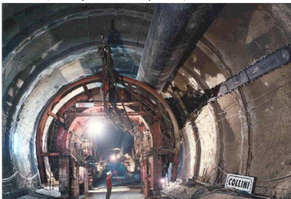
Foto 2. Macchina fresatrice con sega a catena per l'esecuzione del "pretaglio" e scorcio della galleria scavata con tale metodologia
