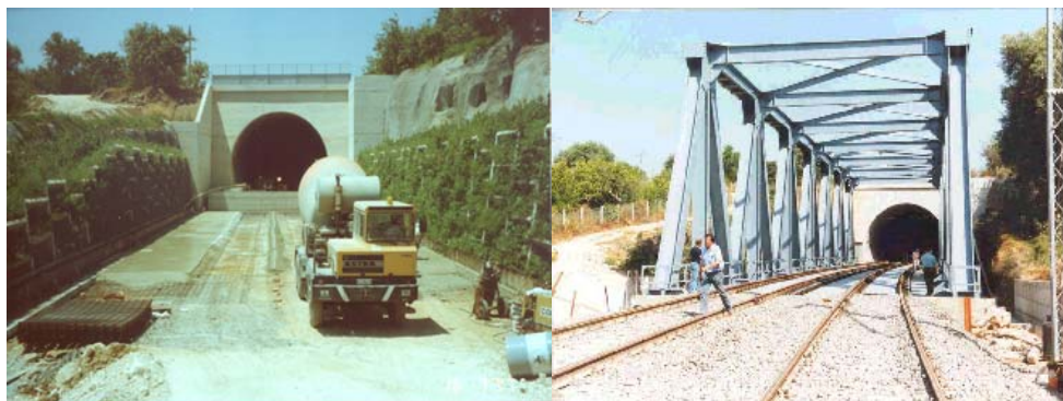
Foto 4 e 5. Opere di conservazione dell'area archeologica presso l'imbocco lato Siracusa (area per collocazione struttura di scavalcamento, sostegno pareti laterali con muri in terra-armata). Sulla destra sono visibili le nicchie funerarie della necropoli del Fusco. – Ponte ferroviario a campata unica con luce 62 m.
