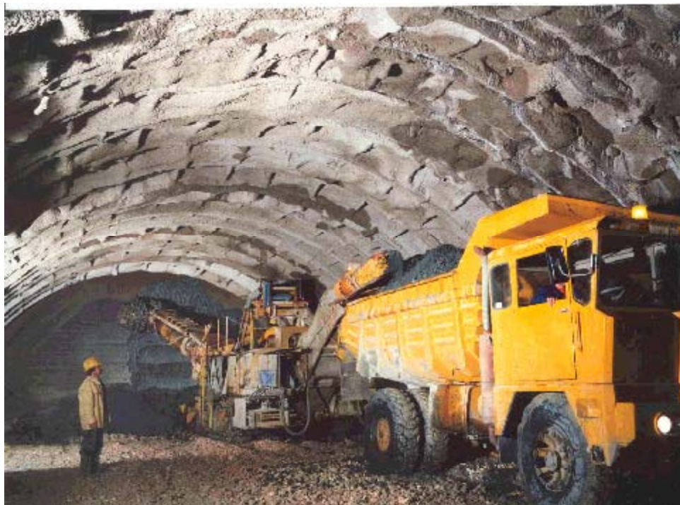
Foto 1. Operazioni di scavo con fresa a controllo computerizzato
