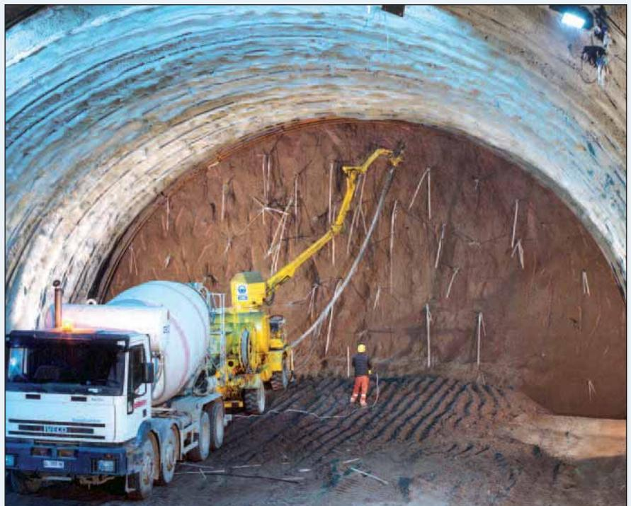
Figura 1 - La galleria Appia Antica (GRA di Roma): le operazioni di consolidamento del nucleo d'avanzamento
