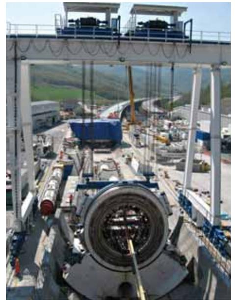
Foto 2 – La TBM-EPB “Martina” durante la fase di montaggio.
