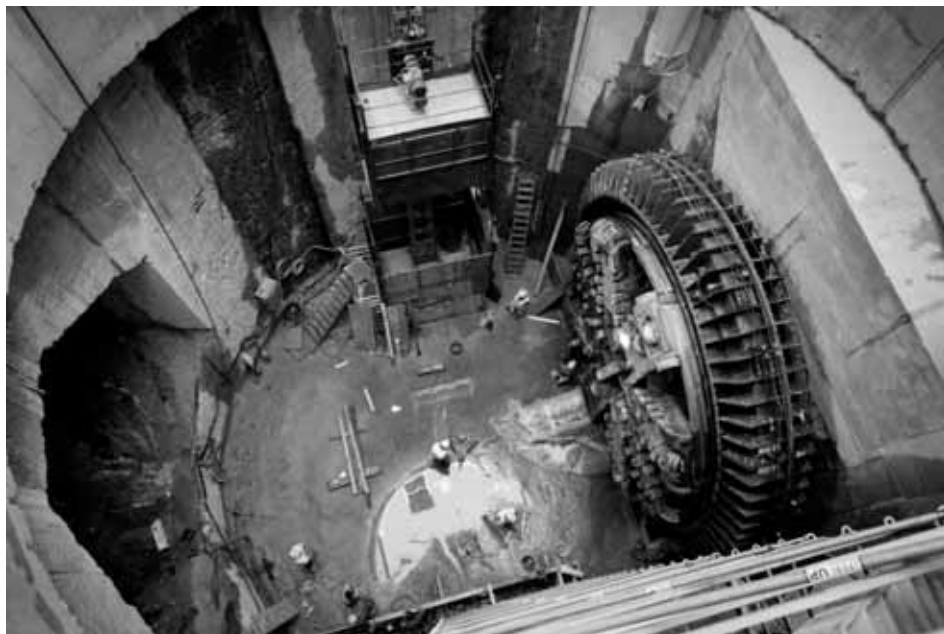
Figura 3. Pozzo 5.4 - estrazione TBM
