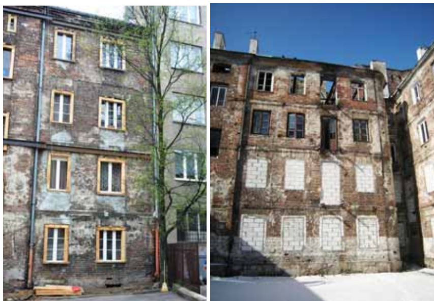
Figura 5 – Interventi strutturali a protezione edifici quartiere Praga
