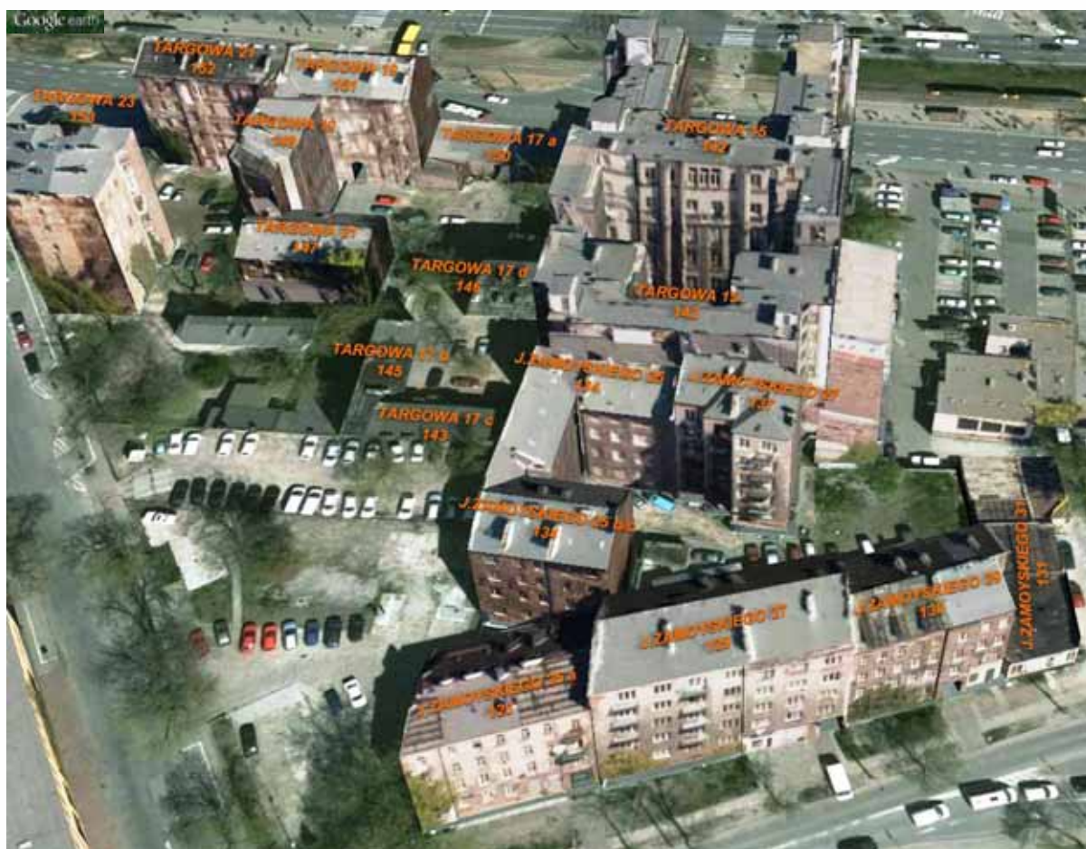
Figura 2 – Varsavia – Complesso monumentale quartiere Praga
