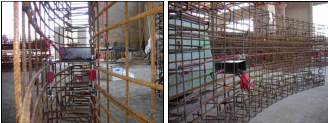
Figura 6 Barrette estensimetriche per calcestruzzo installate sull'armatura dei conci del rivestimento definitivo e scatole metalliche per il futuro alloggiamento del nodo sensore.
