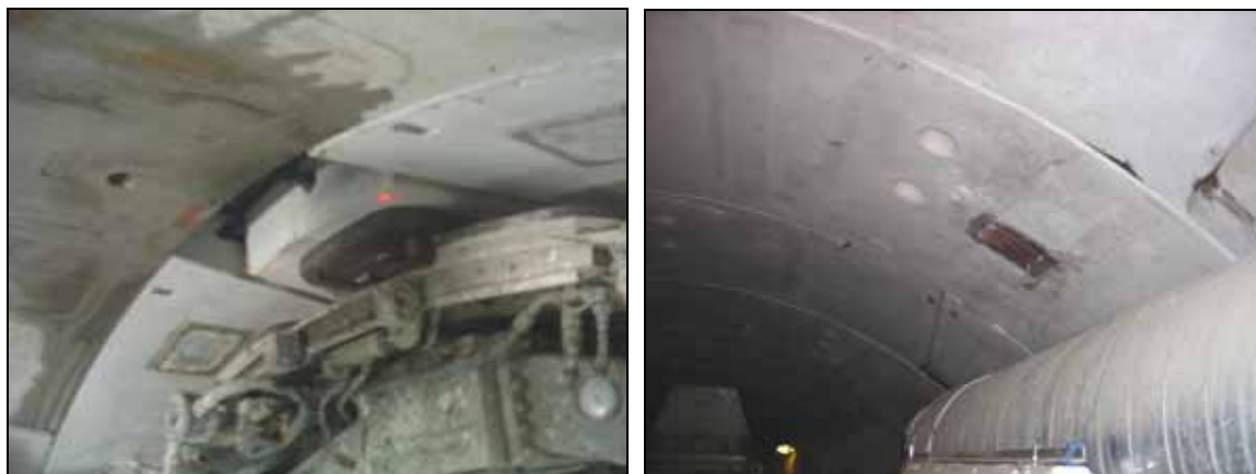
Figura 16 La TBM non consente l'accesso diretto ai dataloggers (immagine a sinistra). Il sistema di areazione può ostacolare l'accesso ai dataloggers (immagine a destra).
