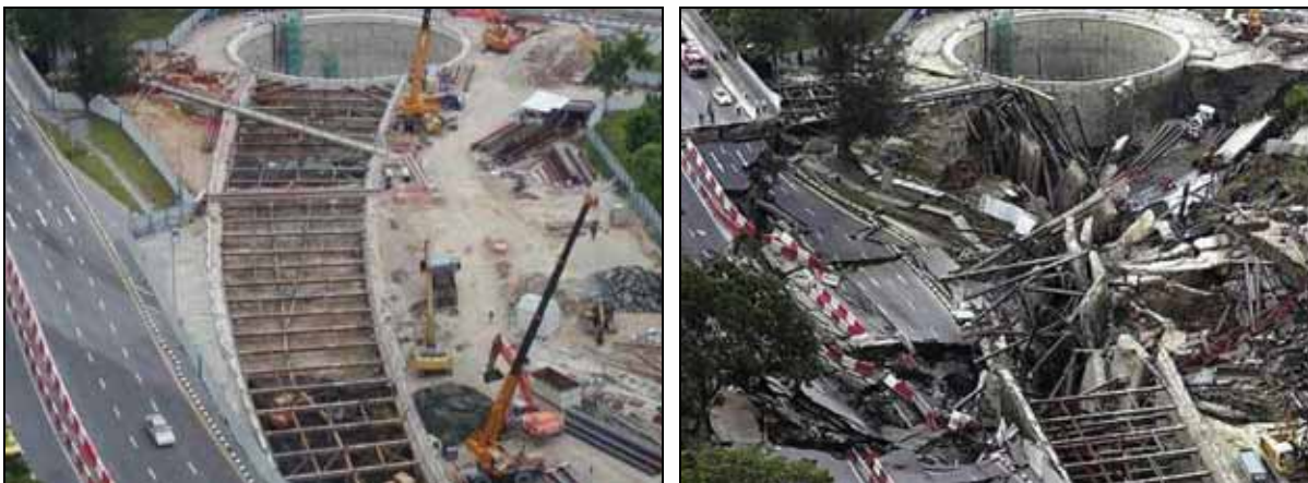
Figura 2 Singapore MRT primavera 2004 prima e dopo il collasso (immagine tratta da internet "The Code of Practice for Risk Management of Tunnel Works ITA Conference Seoul, April 25, 2006").
