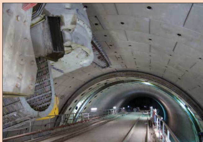
4. La galleria Montedomini: a due fornici adiacenti di lunghezza circa 280 m per carreggiata, è ubicata lungo la A14 Bologna-Taranto nei pressi di Ancona
