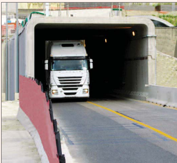
11. La struttura modulare dello scudo di protezione del traffico presso la galleria Montedomini
