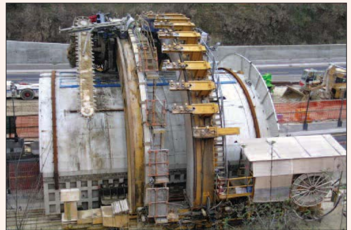
7. L'attrezzatura multifunzione alla galleria Nazzano
