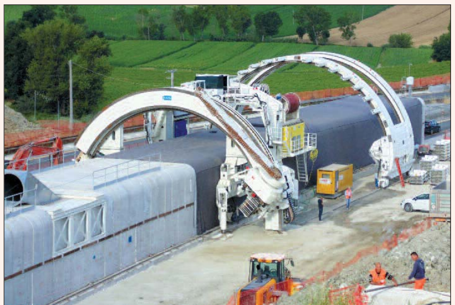
8. La macchina del pretaglio e per la posa dei conchi alla galleria Montedomini
