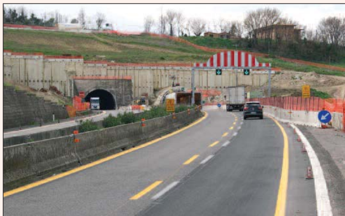
14. I semafori in approccio alla galleria Montedomini
