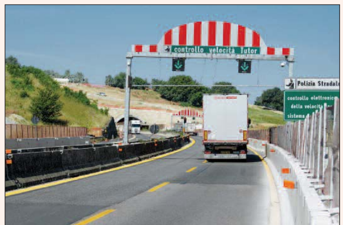
15. Il "portale allarmato" di rilevamento dei mezzi fuori sagoma presso la galleria Montedomini
