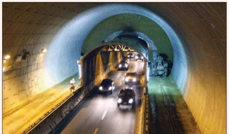
2. Un esempio di scavo di gallerie in presenza di traffico
