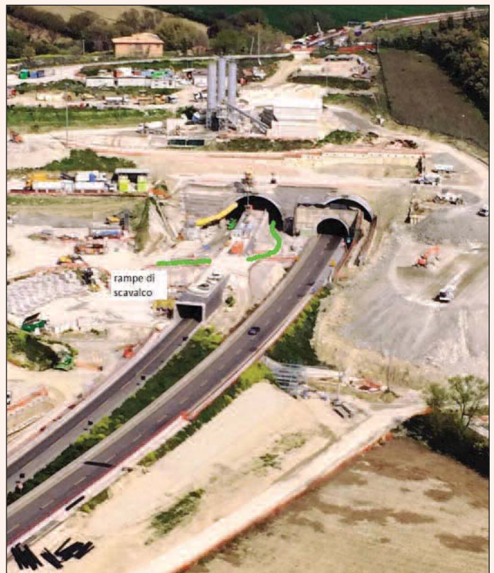
12. Il cantiere dell'imbocco Nord della galleria Montedomini
