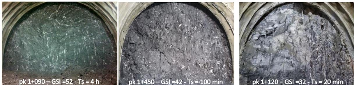
Figura 11: tempi di scavo per 1m di avanzamento con martello demolitore in Finestra Castagnola (area di scavo 100 m<sup>2</sup> ca.)
