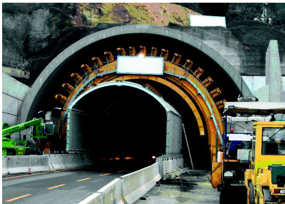
Fig. 13 – Foto della cantierizzazione all'imbocco.
