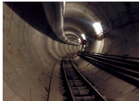
Il rivestimento delle gallerie correnti in conci prefabbricati di c.a.p.
