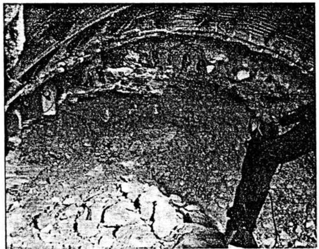
Fig. 9 - Présoutènement par Jet Grouting - Voisinage du terrain traité
