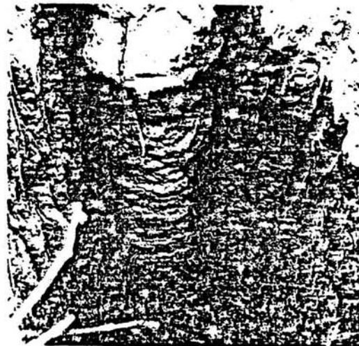
FIG. 12 - MISE A JOUR D'UNE COLONNE CONSOLIDEE DANS LES ALLUVIONS LIMONEUSES DE LA DEFENSE A PARIS (COTES 24 A 30 m NGF)
