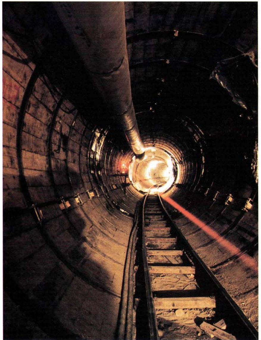
Foto 2 - Metropolitana di Milano Linea 3 (1985) - Cunicolo pilota scavato con scudo meccanizzato ad attacco integrale e continuo.
