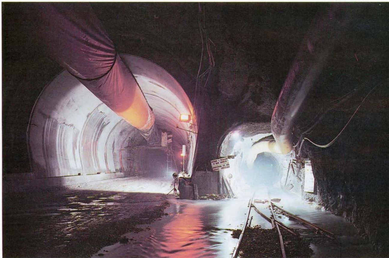
Foto 11 - Galleria FS Zuc del Bor (1986) - Sezione corrente della galleria e imbocco del cunicolo pilota, progr. 2800.
