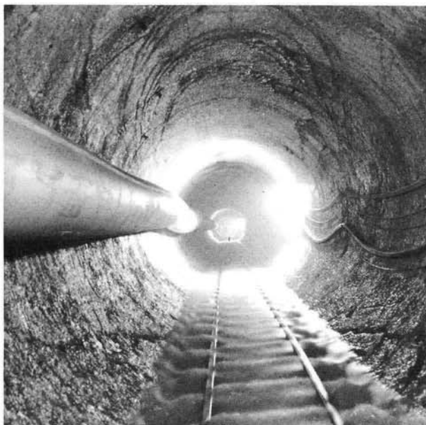
Foto 3 - Galleria FS Zuc del Bor (1986) - Cunicolo pilota scavato con fresa ad attacco integrale e continuo.
