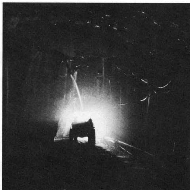
Foto 5 - Traforo Autostradale del Gran Sasso (1973) - Cunicolo drenante.
