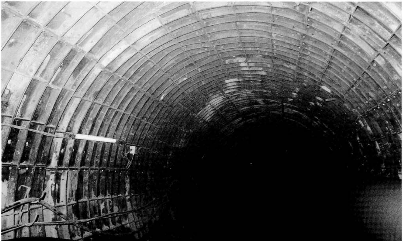
Foto 15 - Foro Pilota Galleria FS Malborghetto (1986) - Bullonatura continua del foro fresato mediante liner-plate in una zona di faglia.
