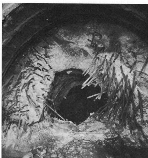
Foto 6 - Traforo Autostradale del Gran Sasso (1973) - Scavo di allargò dopo il consolidamento con iniezioni.
