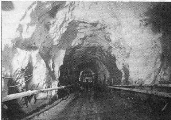
Fig. 18 Profilage obtenu par avancement avec explosif
