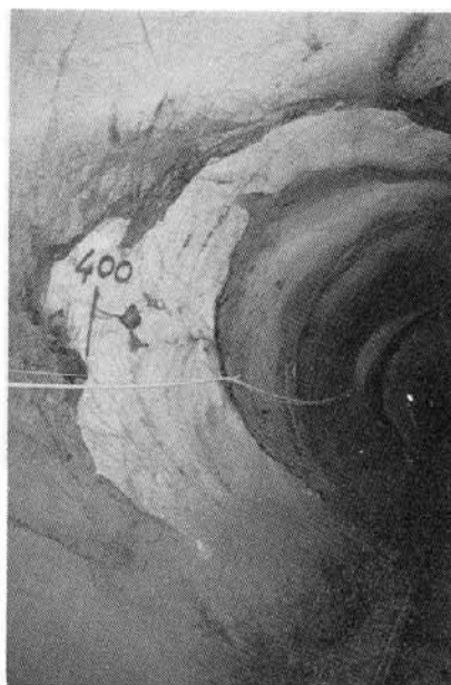
Fig. 10 Galerie \phi 4,20 Zone de "gabbro" avec intrusion
