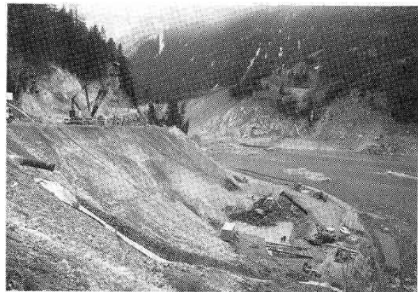
Fig. 6 Réalisation de l'ouvrage de prise en amont
