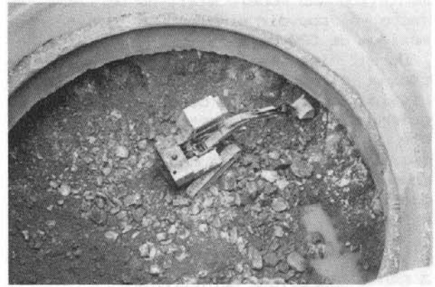
Fig. 12 Phase d'excavation des puits
