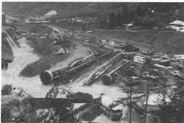
Fig. 15 Les deux tunneliers en phase de montage
