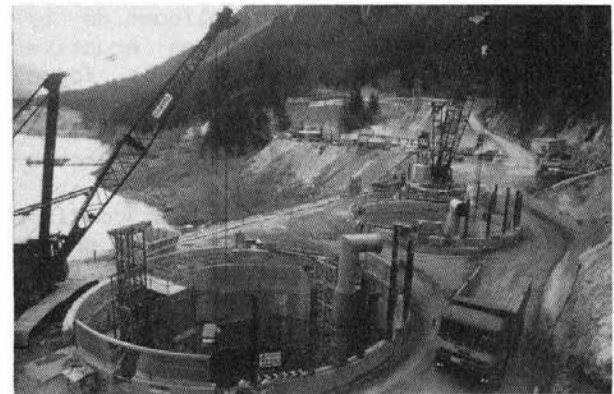
Fig. 13 Vue générale des puits de l'entrée
