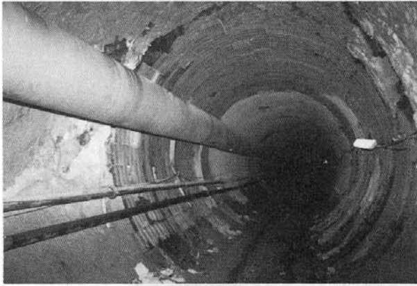
Fig. 11 Galerie \phi 6.00 Zone fracturée avec blindages
