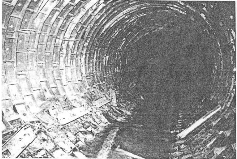
Foto 1: Blindaggio sistematico del foro pilota. Systematic posing of liner plate in the pilot tunnel.
