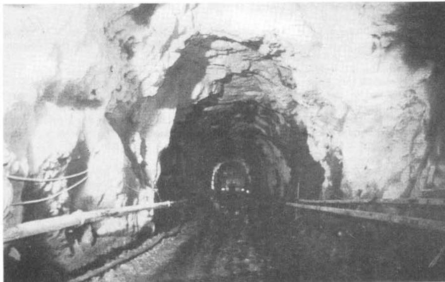
Fig. 14 - Profilatura ottenuta con l'avanzamento mediante esplosivo
