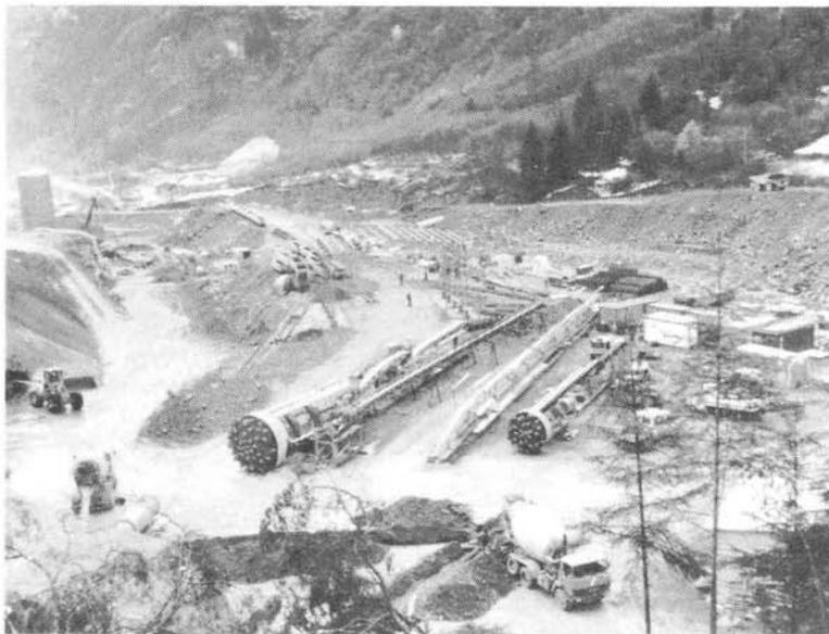
Fig. 13 - Le due frese in fase di montaggio
