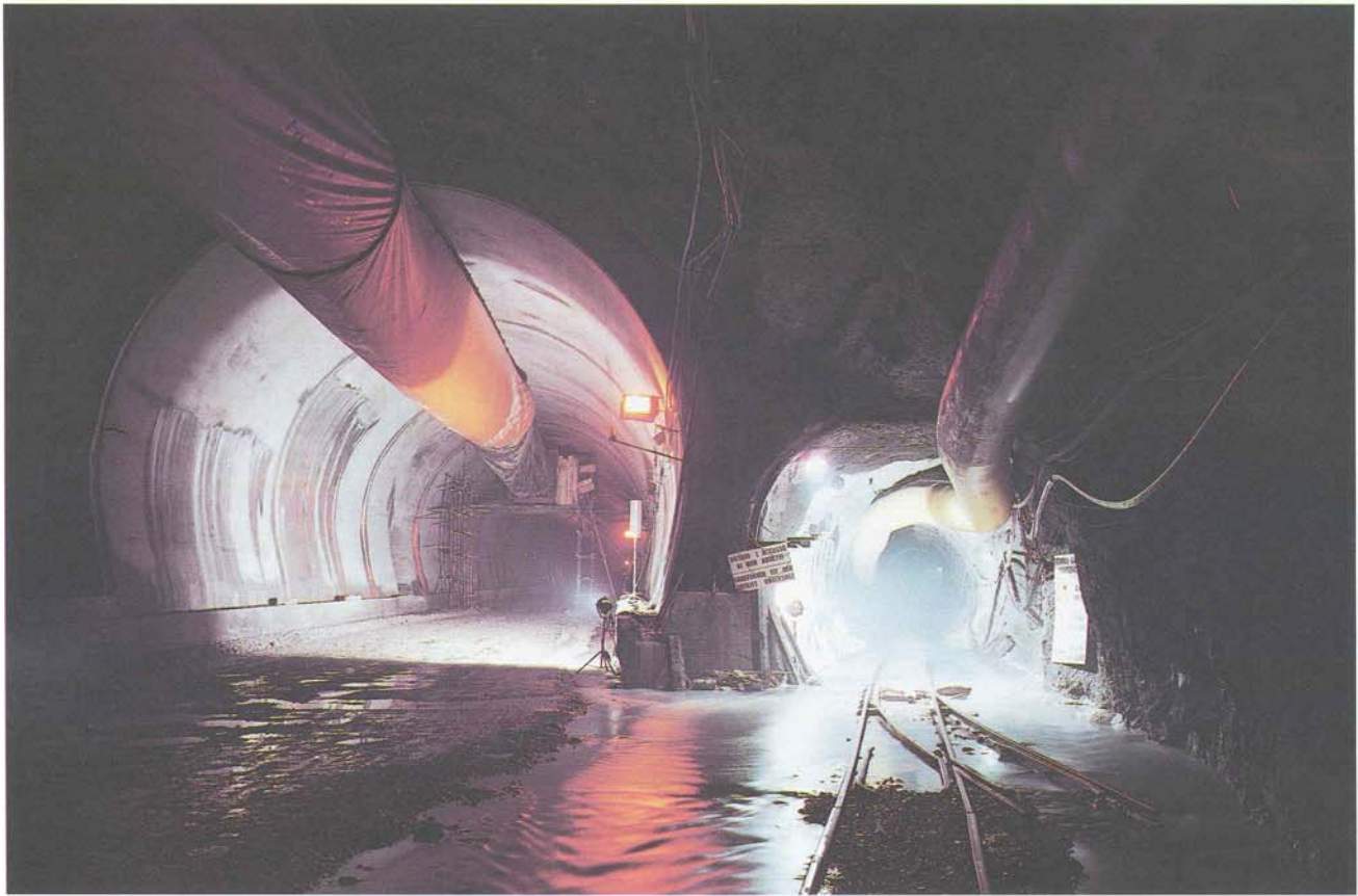
Foto 11 - Galleria FS Zuc del Bor (1986) - Sezione corrente della galleria e imbocco del cunicolo pilota, progr. 2800.
