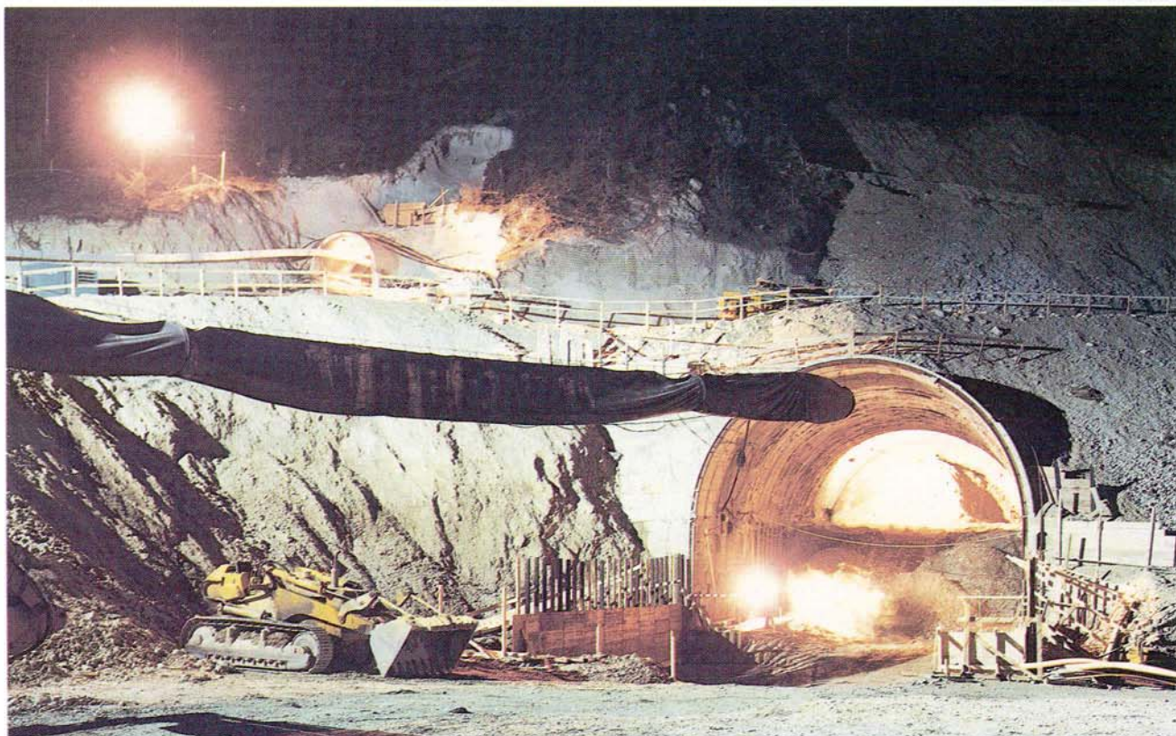
Foto 7 - Galleria FS Zuc del Bor (1984) - Vista dell'imbocco della galleria principale (in basso) e del cunicolo pilota utilizzato per i consolidamenti (in alto).
