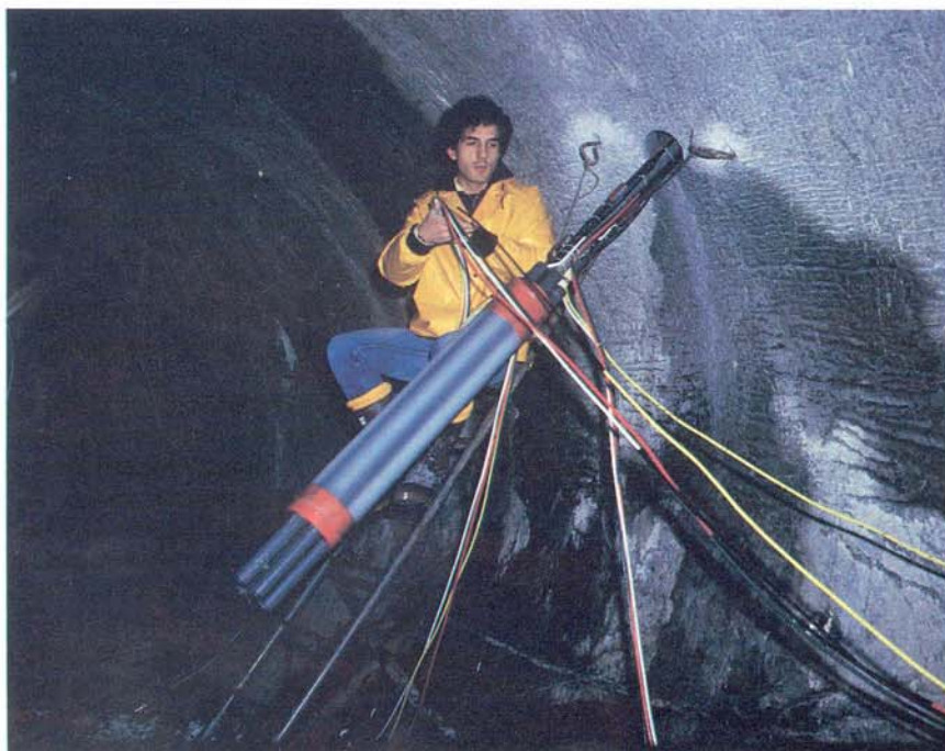
Foto 18 - Foro Pilota Galleria FS Prato Tires, Ponte Gardena (1985) - Messa in opera degli estensimetri «recuperabili».
