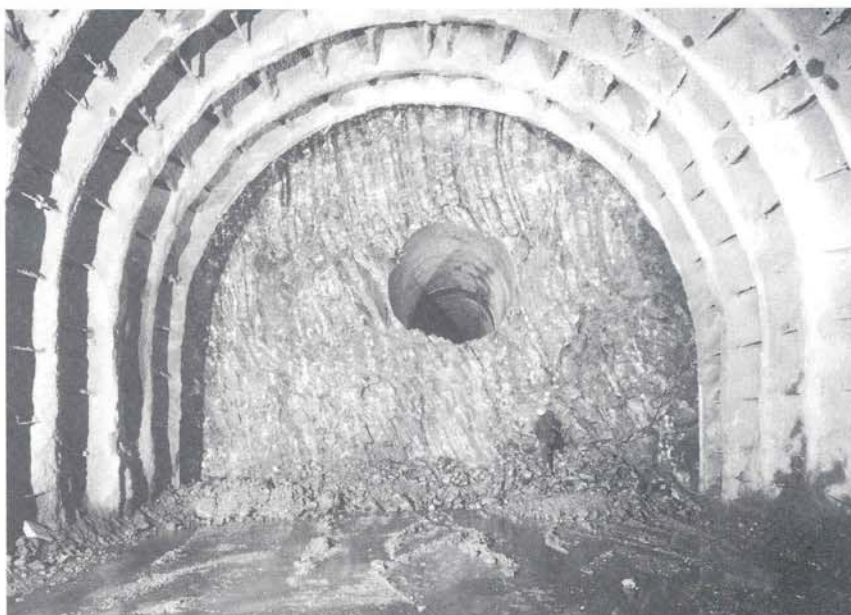
Foto 8 - Galleria Monte Olimpico 2 (1986) - Particolare del foro pilota collocato all'interno della sezione definitiva di scavo, nella zona di calotta.
