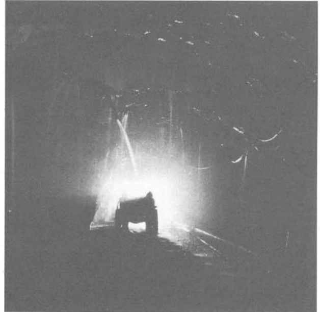
Foto 5 - Traforo Autostradale del Gran Sasso (1973) - Cunicolo drenante.
