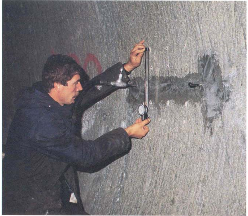
Foto 19 - Foro Pilota Galleria FS Prato Tires, Ponte Gardena (1985) - Prove in sito.
