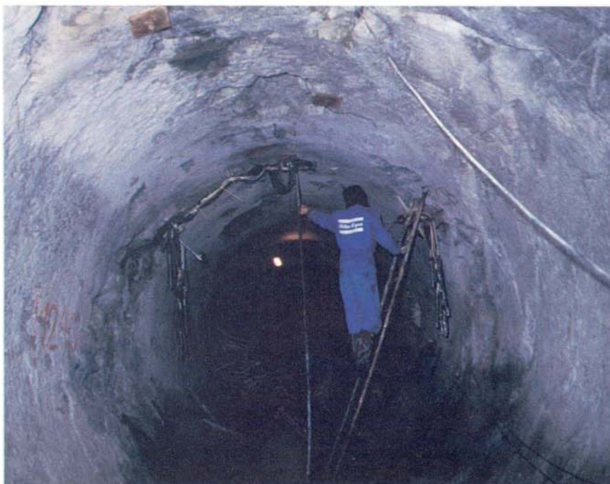
Foto 17 - Foro Pilota Galleria FS Prato Tires, Ponte Gardena (1985) - Messa in opera degli estensimetri «recuperabili».
