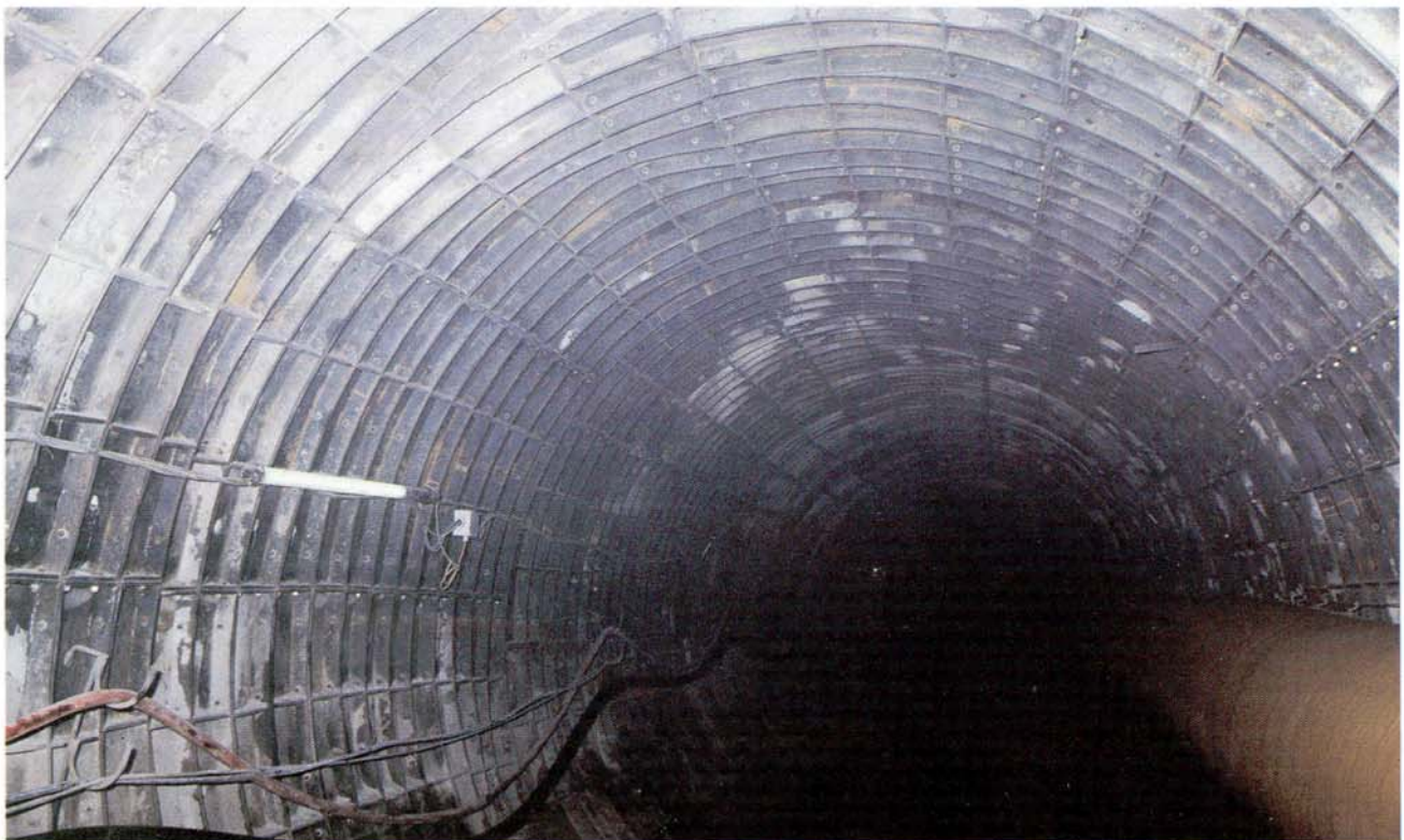
Foto 15 - Foro Pilota Galleria FS Malborghetto (1986) - Bullonatura continua del foro fresato mediante liner-plate in una zona di faglia.
