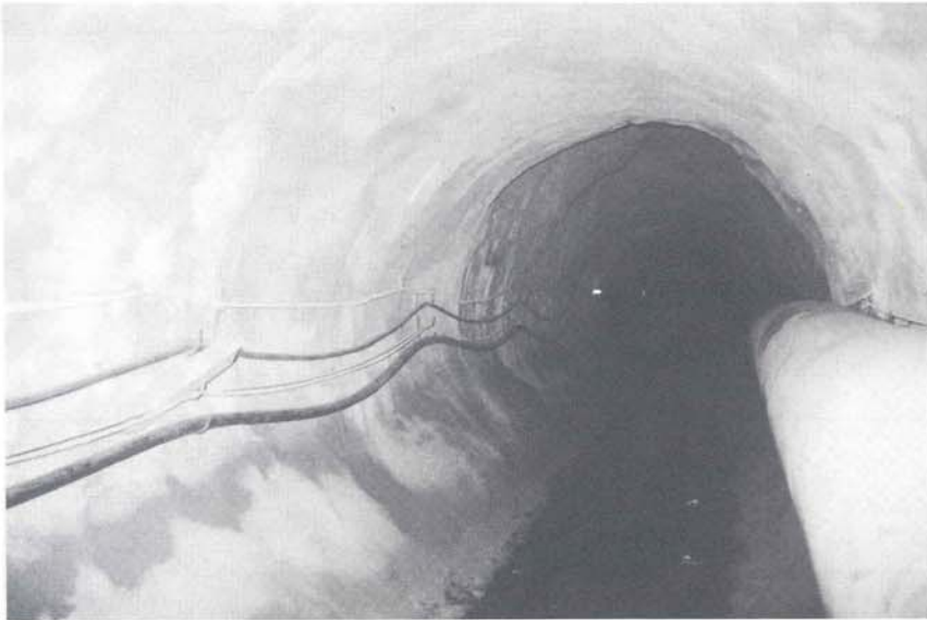
Foto 14 - Foro Pilota Galleria FS Zuc del Bor (1986) - Zona con applicazione sistematica spritz-beton.
