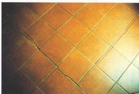
Lesione di un pavimento dell'abitato «La Beccia»
