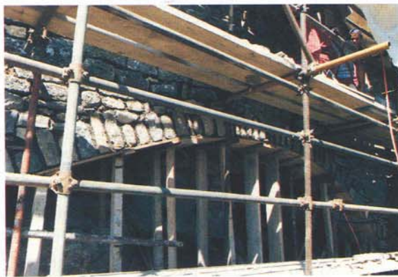
Foto 7 - Interventi di muratura e stilatura
