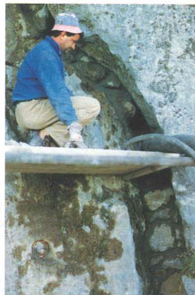
(a sinistra) Foto 4 - Perforazione nel settore del «Sasso Spicco» in condizioni di elevato disagio (sotto) Foto 5 - Tetto del masso aggettante denominato «Sasso Spicco» interessato da chiodature e tirantature (a destra) Foto 6 - Operazioni di riempimento delle principali fessure e cavità presenti
