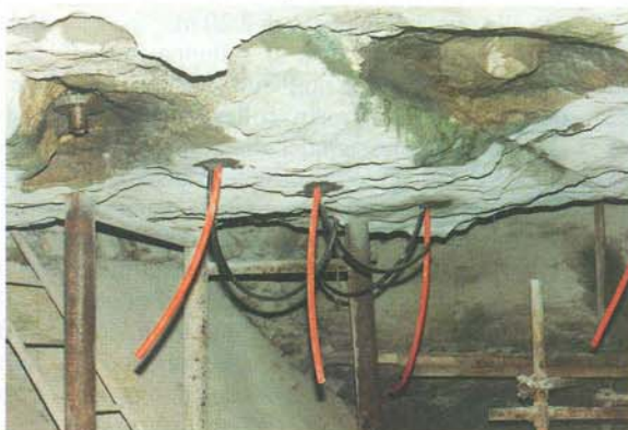
(a sinistra) Foto 4 - Perforazione nel settore del «Sasso Spicco» in condizioni di elevato disagio (sotto) Foto 5 - Tetto del masso aggettante denominato «Sasso Spicco» interessato da chiodature e tirantature (a destra) Foto 6 - Operazioni di riempimento delle principali fessure e cavità presenti
