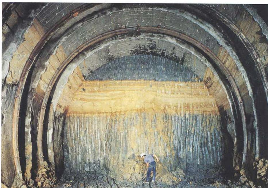
**Galleria in costruzione sulla ferrovia Sibari—Cosenza: nucleo d'avanzamento costituito da terreno argilloso con lenti di sabbia, protetto da gusci di calcestruzzo spruzzato fibrorinforzato realizzati mediante pretaglio meccanico (foto Rocksoil).**
