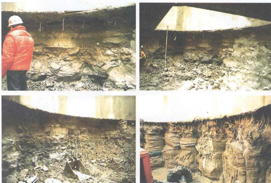
presenza, alcuni metri sotto il p.c., di clasti nonché dalla natura ed eterogeneità del sottosuolo e da elevate temperature di idratazione del cemento.
