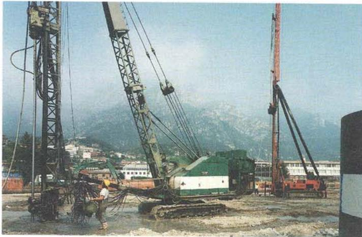
Fig. 12 - Esecuzione jet-grouting
