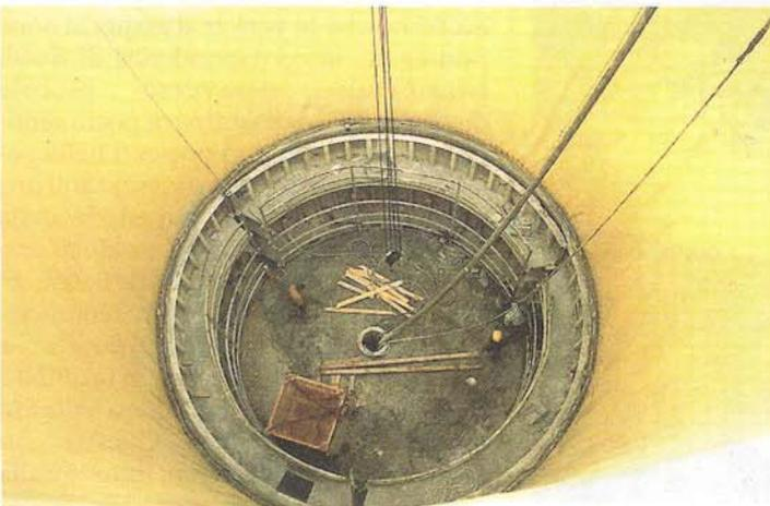
Fig. 20 - Armatura del rivestimento interno (II° concio)
