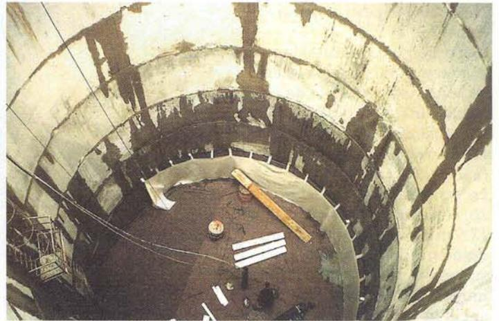
Fig. 18 - Posizionamento geotessile e guaina a fondo pozzo
