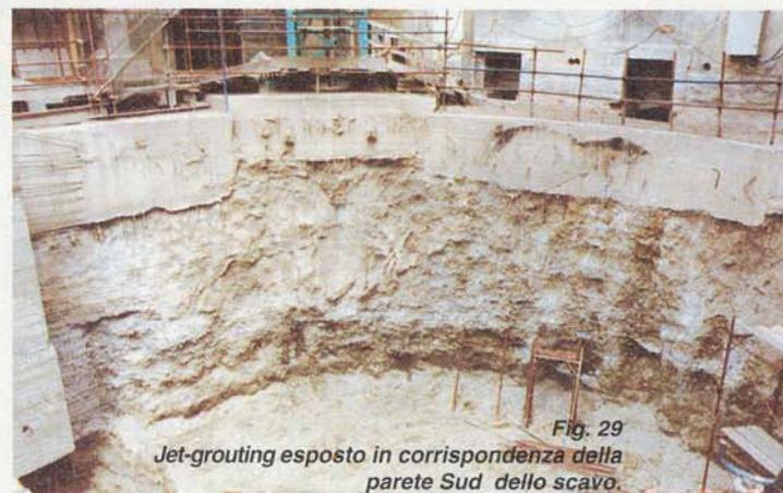
Fig. 29 Jet-grouting esposto in corrispondenza della parete Sud dello scavo.
