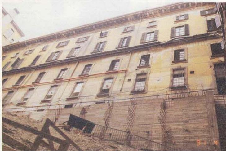
solidato, e con livellazioni topografiche di precisione, su mire fisse applicate sulle facciate perimetrali al cortile. Le suddette rilevazioni hanno innanzitutto permesso di verificare che l'esecuzione dei trattamenti jet-grouting, con
