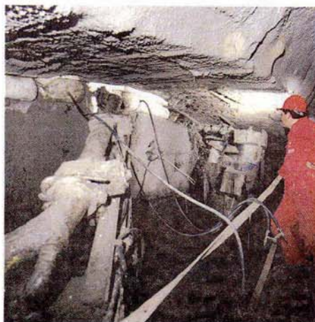
▼ FOTO 4 - Esecuzione del pretaglio e suo riempimento con calcestruzzo pompato previo utilizzo di speciali casseri pneumatici tubolari
