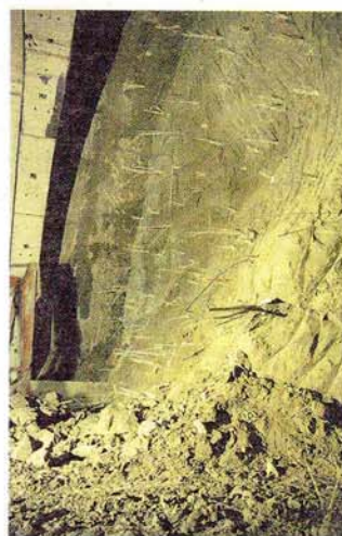
▼ FOTO 4 - Esecuzione del pretaglio e suo riempimento con calcestruzzo pompato previo utilizzo di speciali casseri pneumatici tubolari
