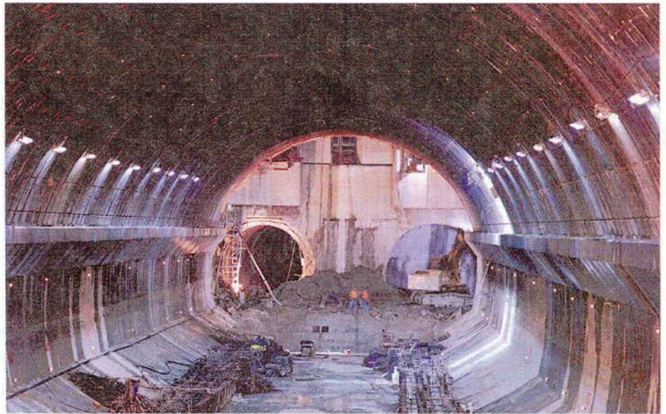
▲ FOTO 7 - Scavo e getto dell'arco rovescio
