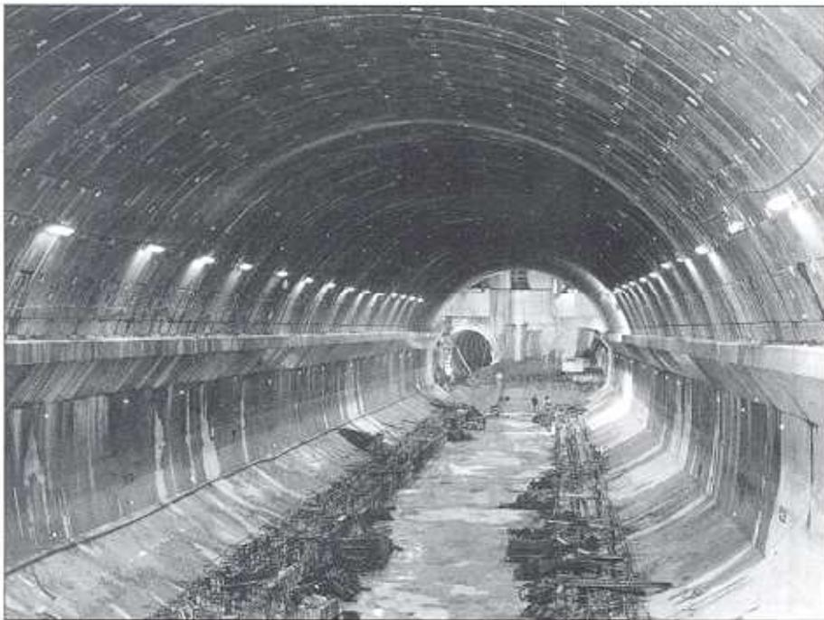
Figure 16: Vue de la station Baldo degli Ubaldi pendant la construction du radier
