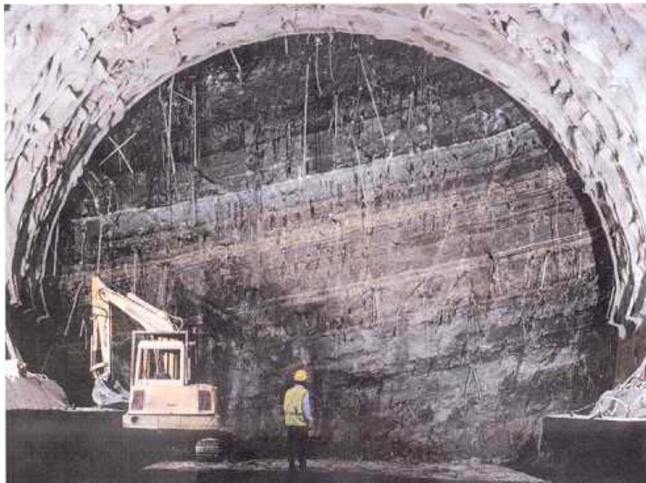
Foto 3 - Fronte consolidato mediante elementi strutturali di vetroresina
