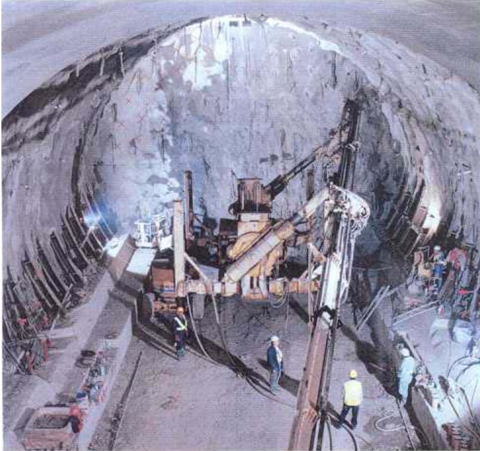
Foto 1 - Fase di consolidamento del nucleo d'avanzamento
