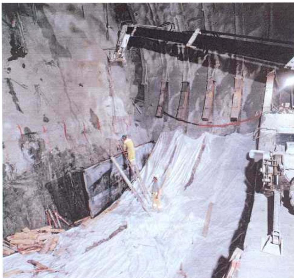
Foto 4 - Preparazione del getto dell'arco rovescio, si noti la *jambe de force*
