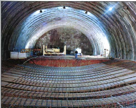
Foto 7 e 8: Galleria dell'Appia Antica: l'armatura e il getto dell'arco rovescio avvengono entro 14 m dal fronte mentre contemporaneamente viene operato il consolidamento del nucleo d'avanzamento con elementi strutturali di vetroresina
