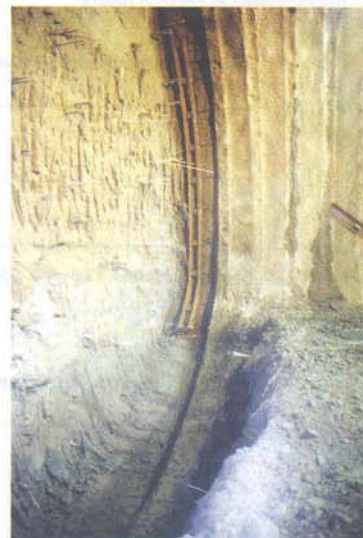
Figura 18 - Particolare dello scavo per il posizionamento del puntone a ridosso del fronte
