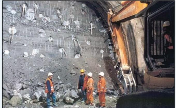
Galleria Firenzuola: il nucleo-fronte consolidato mediante micro-jet-grouting armato con elementi strutturali di vetroresina (terreno: sabbie argillose con intercalazioni ghiaiose; copertura di 50 m)
