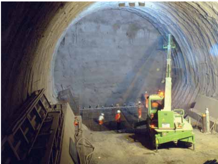
Foto 3 – Il getto dell'arco rovescio vicino al fronte di scavo.
