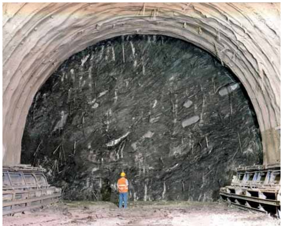
Foto 2 – Fronte nelle argille scagliose consolidato con armature di vetroresina.
