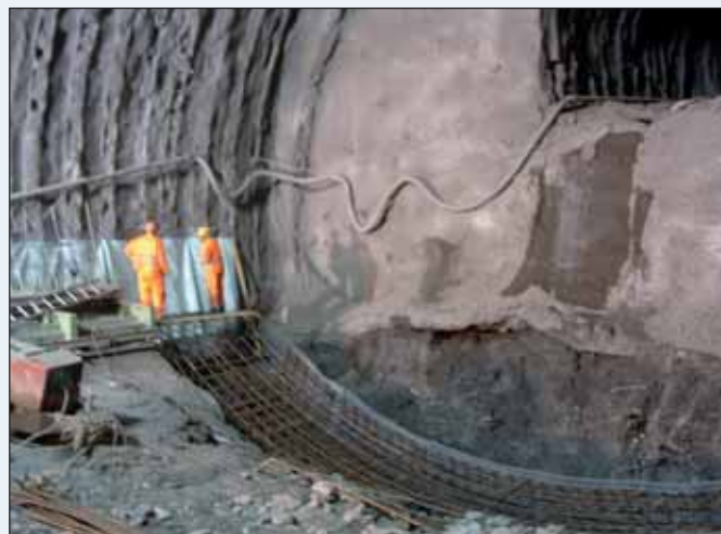
Figura 17 - Lo scavo e il getto dell'arco rovescio nella sezione tipo C2
