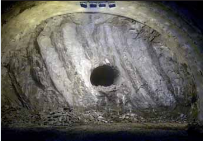
Figura 3 - Il cunicolo pilota dall'imbocco lato Bologna
