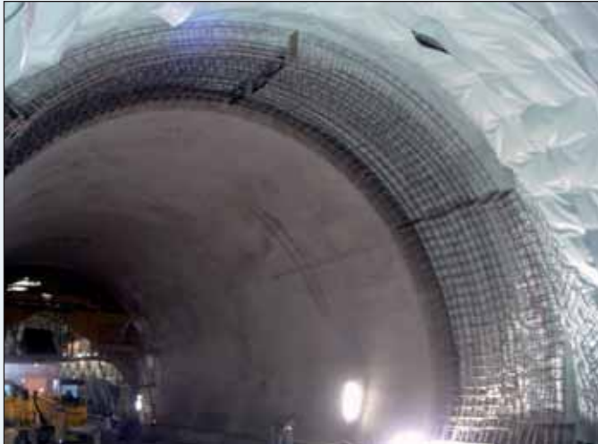
Figure 18A e 18B - Il getto del rivestimento definitivo (A) e le distanze di getto (B)
