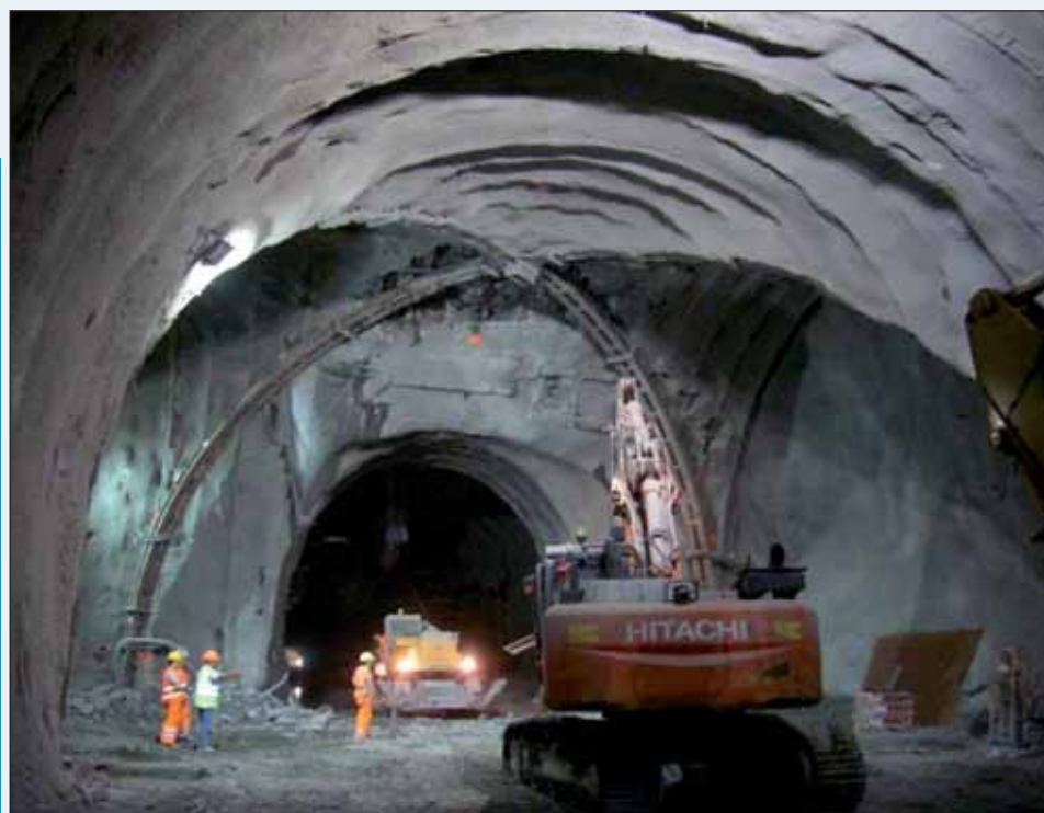
Figura 1 - L'innesto a crociera per il by-pass Poggiolino
