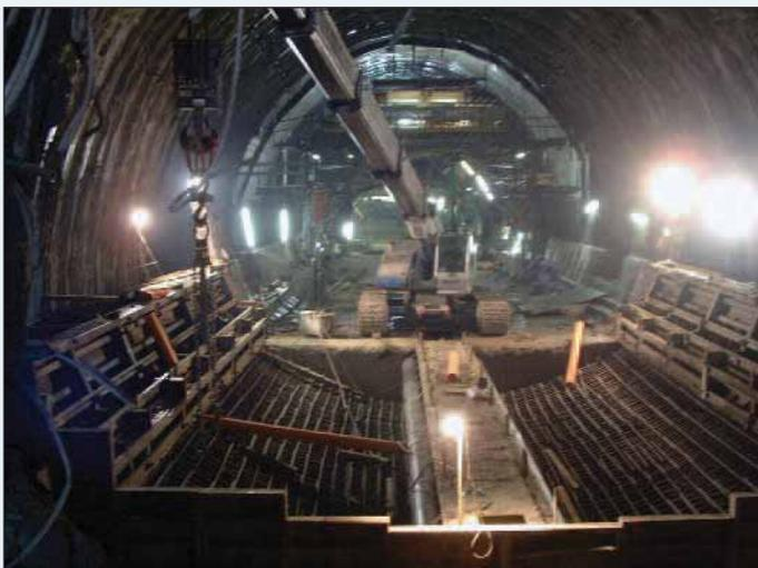
Figure 20A, 20B e 20C - Fasi esecutive sez.C2p/P: posa dell'armatura e getto dell'arco rovescio e murette a completamento del pozzo
