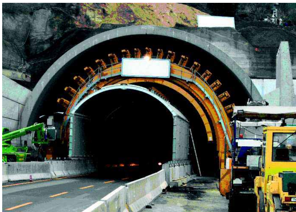
Fig. 13 - Foto della cantierizzazione all'imbocco.
