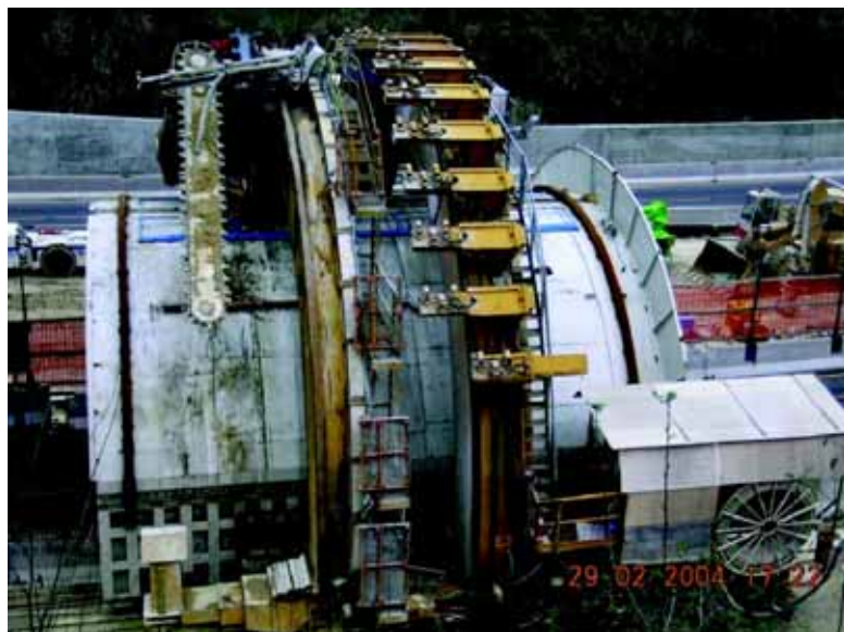
Fig. 14 – L'attrezzatura multifunzione nell'area di stazionamento.
