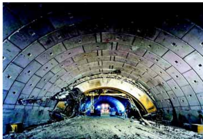
Fig. 4 – Stazione Baldo degli Ubaldi (progetto Rocksoil S.p.A.): la macchina multifunzione per pretaglio e posa conci.
