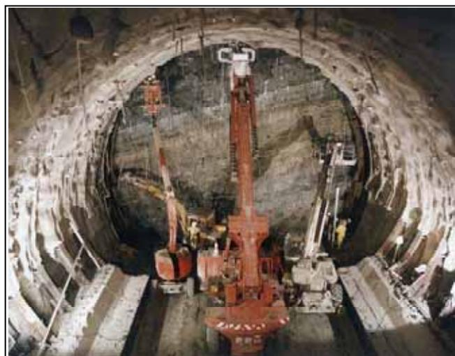
Figura 3. Túnel “Tartaiguille” (França), ( $\varnothing = 15,30$  m, Terreno: argilas dilatantes, Cobertura máx: 150 m.
