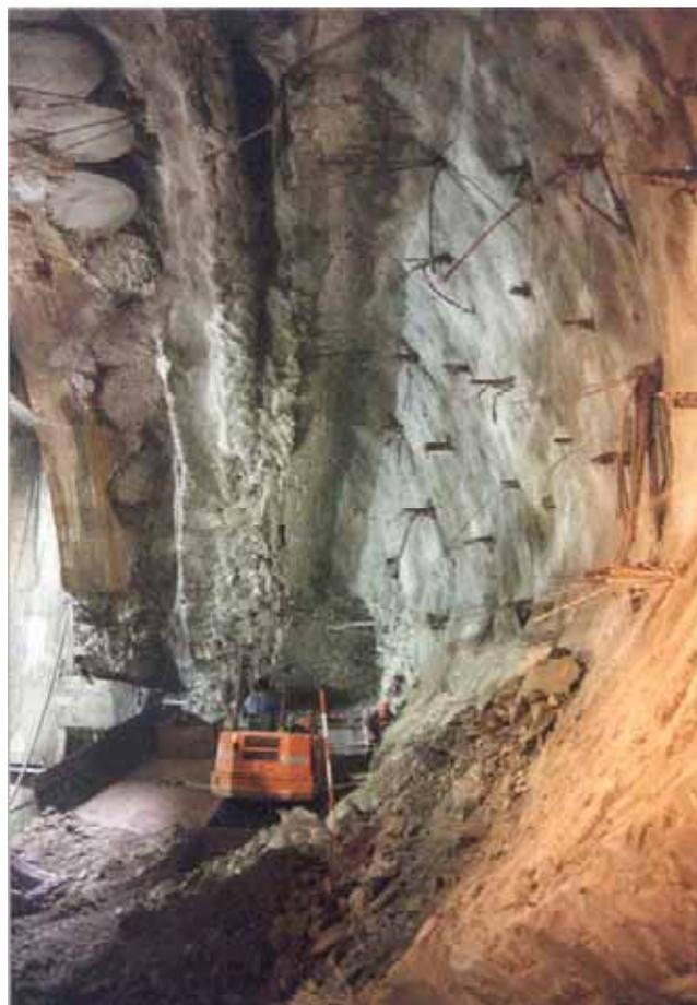
Figura 13. Frente de escavação com forma côncava – Túnel da estação “Baldo degli Ubaldi” - ( $\varnothing = 21,5$  m, Terreno: argilas, Cobertura:  $15 \div 18$  m)
