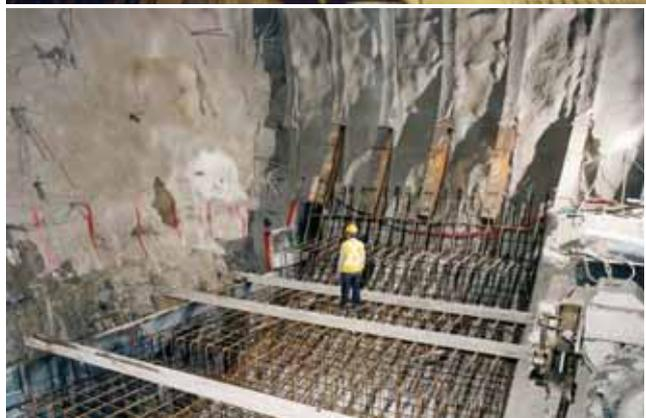
Figura 15. Invert realizado próximo à frente de escavação - Túnel "Raticosa" ( $\varnothing = 13,90$  m, Terreno: argilas escamosas, Cobertura: 500 m) e túnel "Tartaiguille" ( $\varnothing = 15,30$  m, Terreno: argilas dilatantes, Cobertura máx: 150 m).
