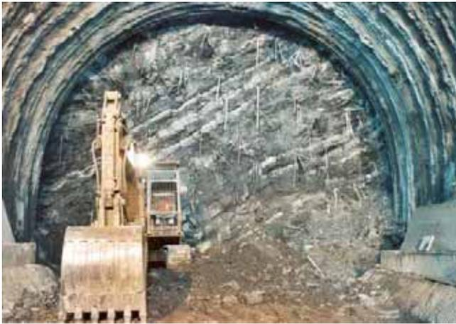
Figura 23. Túnel “Monte Bibele” - O núcleo-frente reforçado com agulhamento em “fiberglass” (terreno: flysch di Monghidoro).
