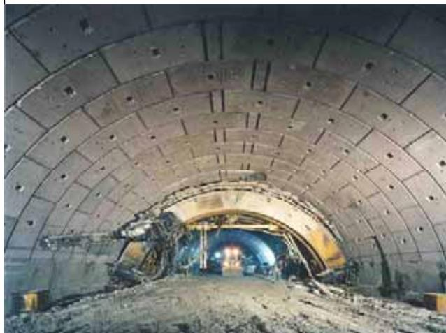
Figura 12. Pré-corte mecânico – Túnel da estação “Baldo degli Ubaldi” - ( $\varnothing = 21,5$  m, Terreno: argilas, Cobertura:  $15 \div 18$  m)
