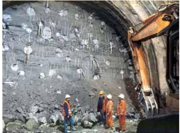
Figura 24. Túnel “Firenzuola” - O núcleo-frente consolidado com micro-jet-grouting armado (terreno: areias argilosas com intercalações de cascalhos).
