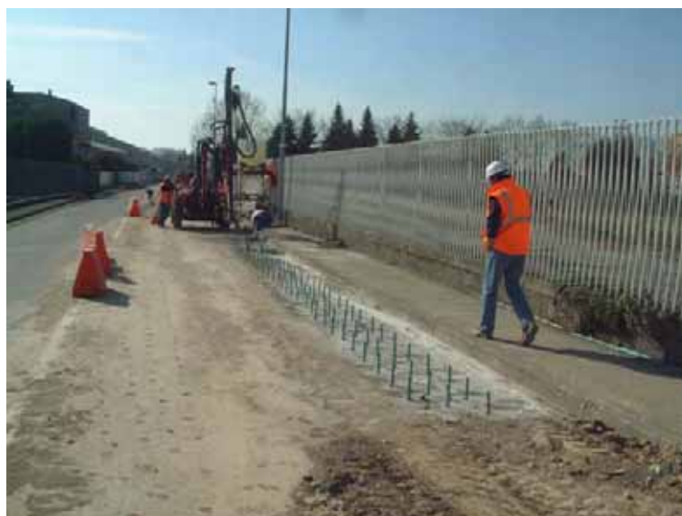
Figura 6 – Attività di consolidamento dalla superficie
