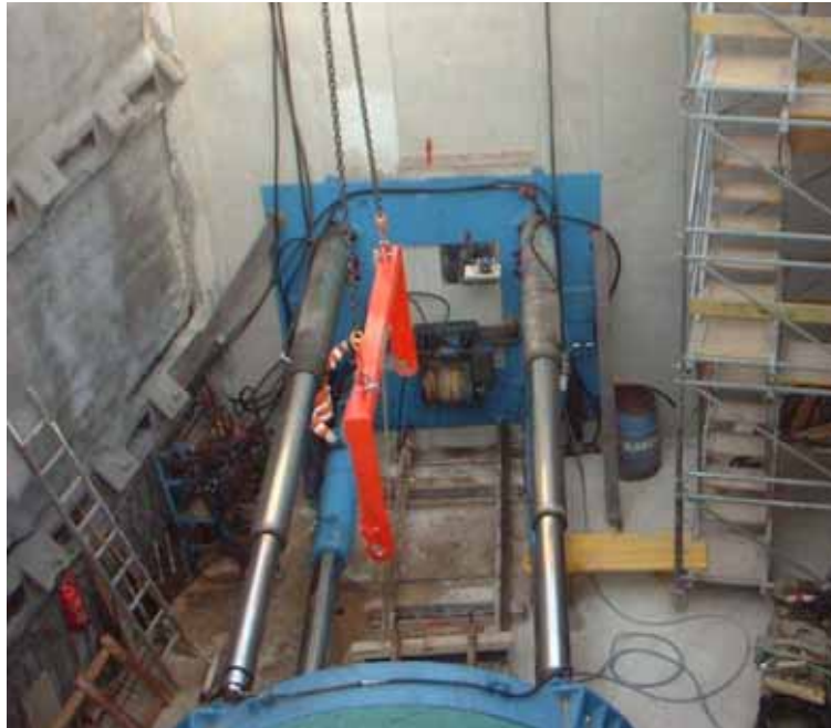
Figura 1 - Attrezzatura di spinta
