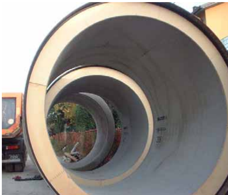
Figura 2 - Elementi prefabbricati di rivestimento
