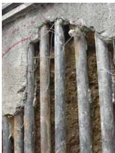
Figura 4 - Dettaglio fronte consolidato
