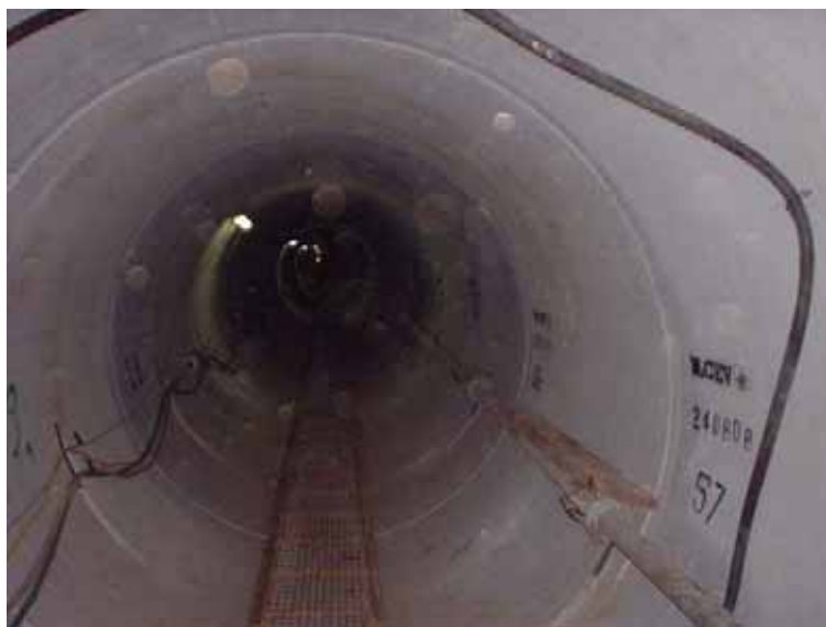
Figura 3 - Vista interna collettore
