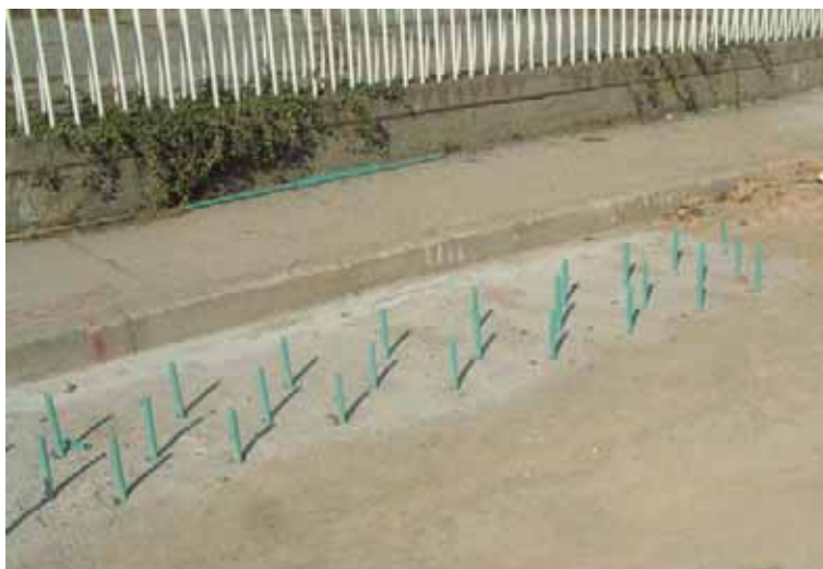
Figura 7 – Dettaglio canne di iniezione
