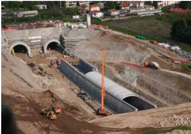
Figura 15. Fasi di partenza degli avanzamenti (imbocco lato Cassano Magnago)
