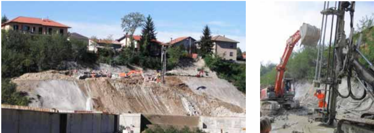
Figura 18. Le fasi esecutive: preparazione dei piani di lavoro ed esecuzione dei trattamenti
