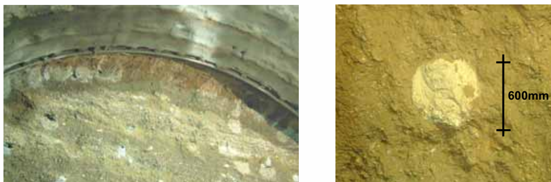
Figura 8. Trattamenti jet "monofluido" (600 mm)
