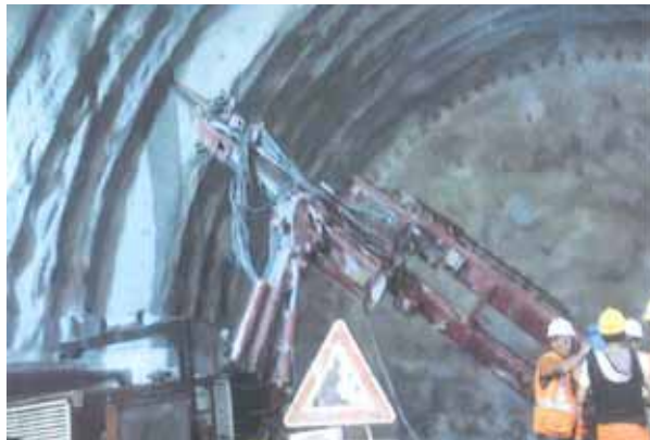
Figura 11. Controlli in galleria (trattamenti in jet-grouting, L=18 m spessore 150 cm)
