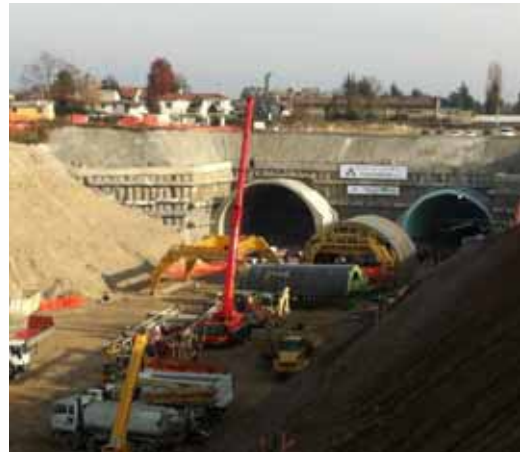
Figura 15. Fasi di partenza degli avanzamenti (imbocco lato Cassano Magnago)
