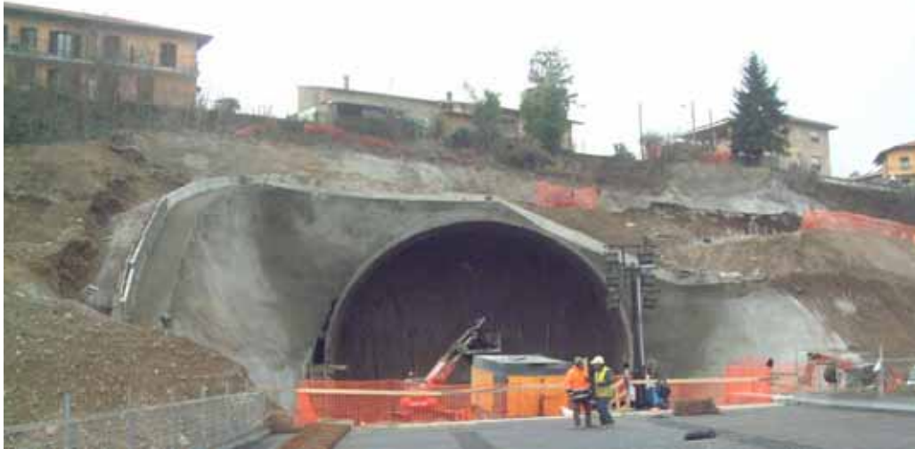
Figura 20. L'imbocco predisposto per lo scavo (canna est)
