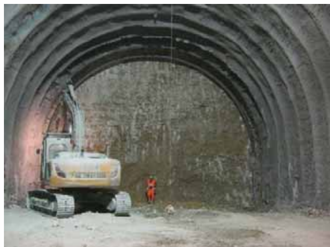
Figura 2. Campo Prove: a) Confronto Domini di Resistenza; b) Installazione della centina tubolare.
