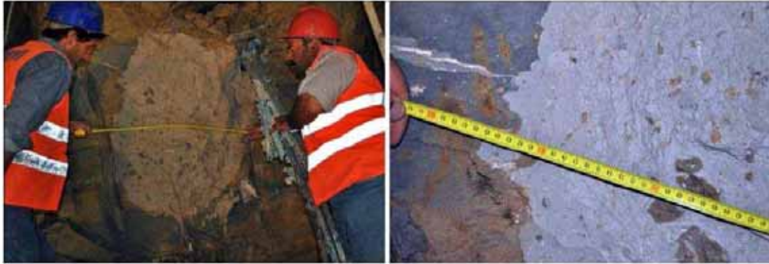
Figura 16 – Foto rappresentative delle colonne in jet grouting ottenute nel campo prova
