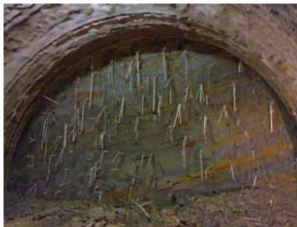
Figura 4 – Fronte di scavo nelle argille marnose
