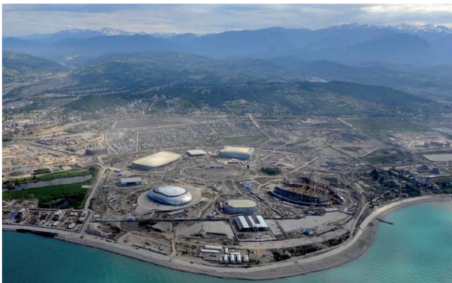
Panoramica della zona olimpica di Sochi. Sullo sfondo le montagne del Caucaso interessate dai lavori del "Dubler Kurortnogo prospekta".
