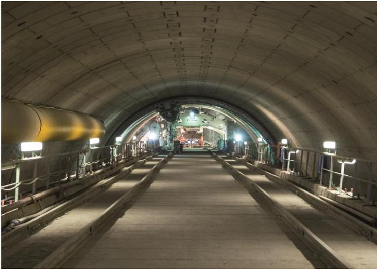
figura 19 – Galleria Montedomini: la copertura dello scudo in c.a. come area di cantiere
