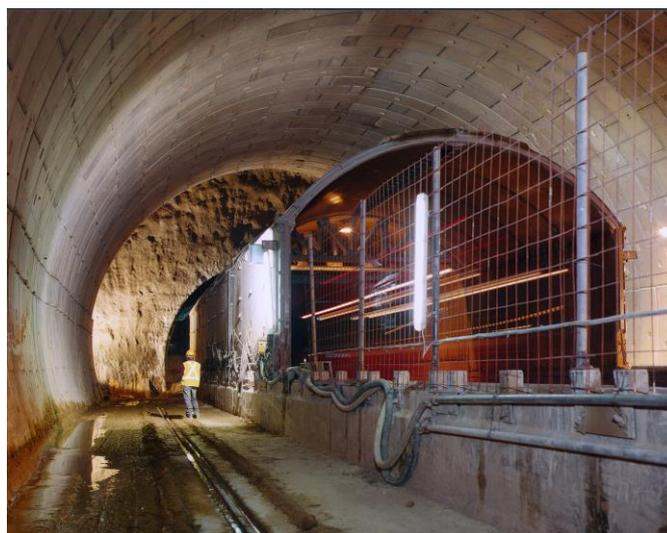
figura 8 – Galleria Nazzano: Scudo di protezione del traffico in Acciaio
