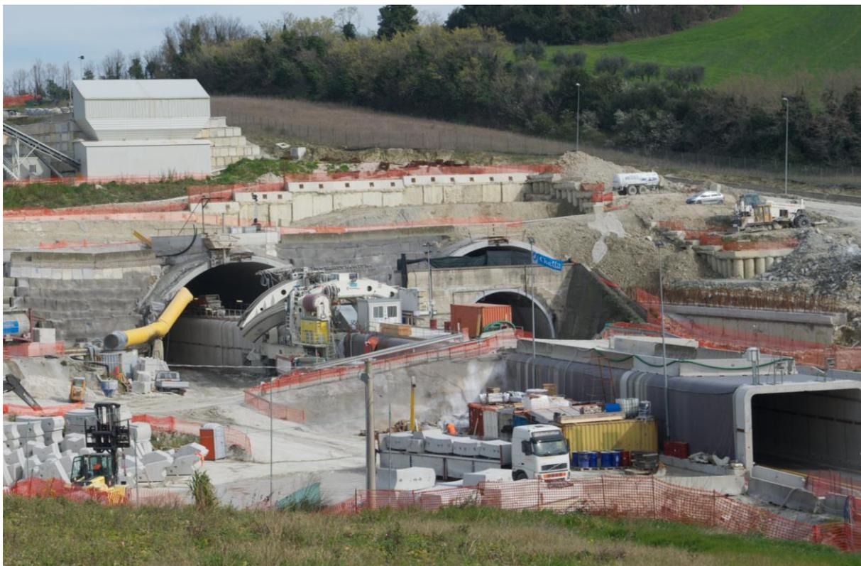
**figura 15 – Galleria Montedomini: vista imbocco Nord dello scudo di protezione del traffico in C.A. e della rampa di scavalco autostradale**
