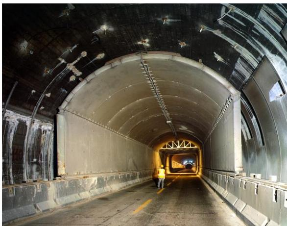
figura 2 – Scudo di protezione del traffico in Acciaio
