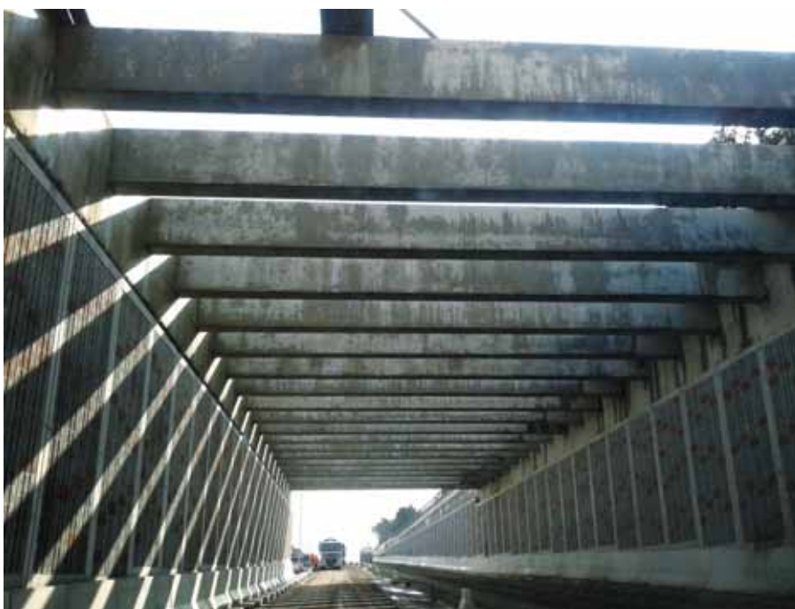
Figura 3 – Rampa d'ingresso in galleria: tratta puntonata
