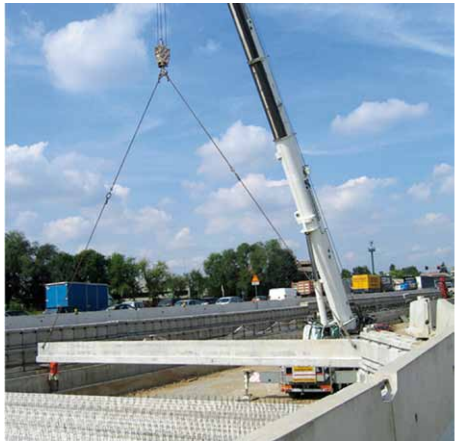
Figura 8 – Posizionamento delle travi prefabbricate di copertura
