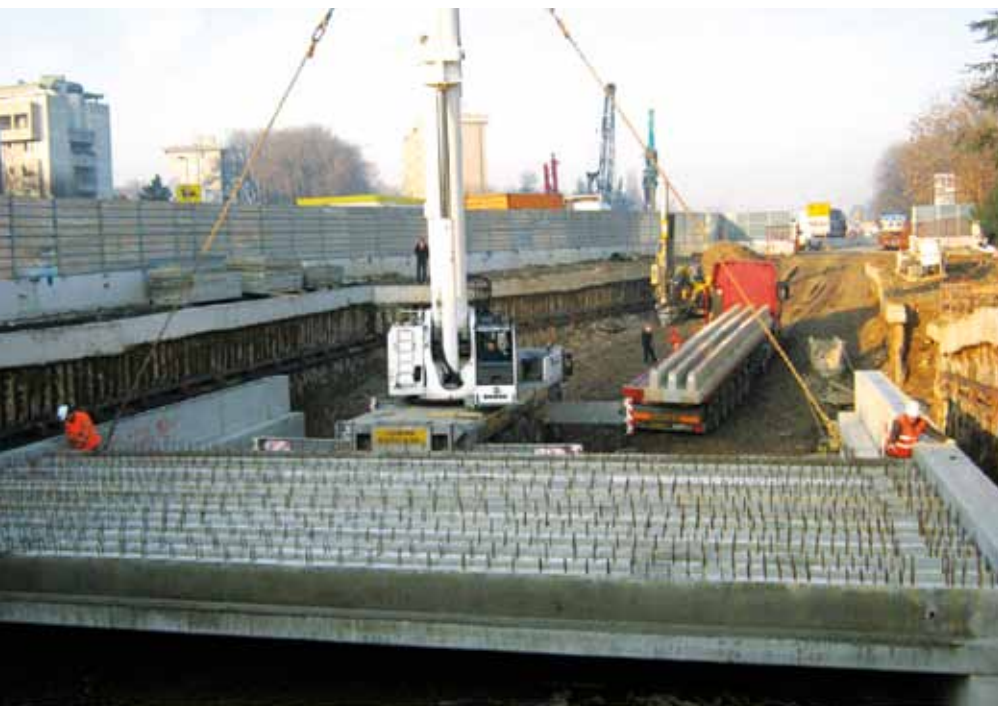
Figura 9 – Posa delle travi prefabbricate di copertura
