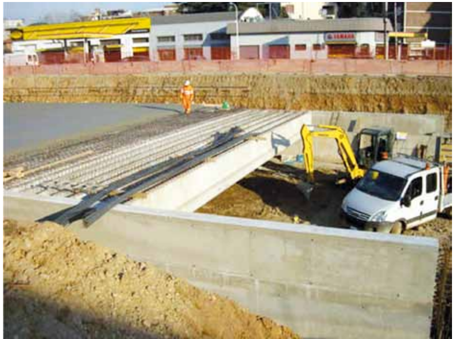
Figura 10 – Getti di completamento della copertura
