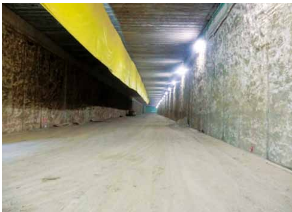
Figura 12 – Vista interna della galleria completa
