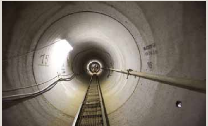
Particolare della condotta in fase di esecuzione
