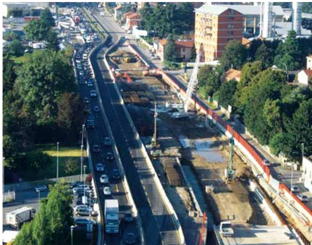
Figura 5 - Fasi di lavoro con viabilità modificata
