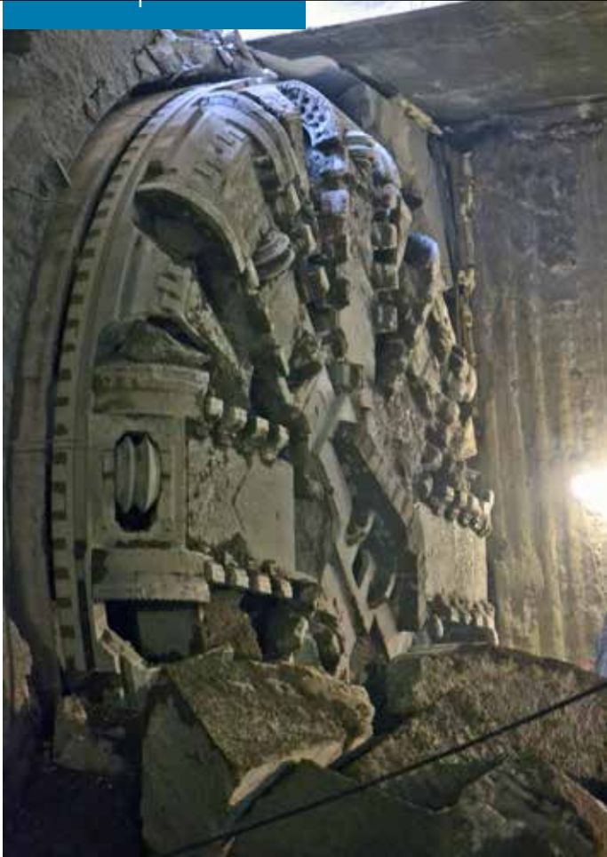
35. Il break in della TBM alla stazione Świętokrzyska
