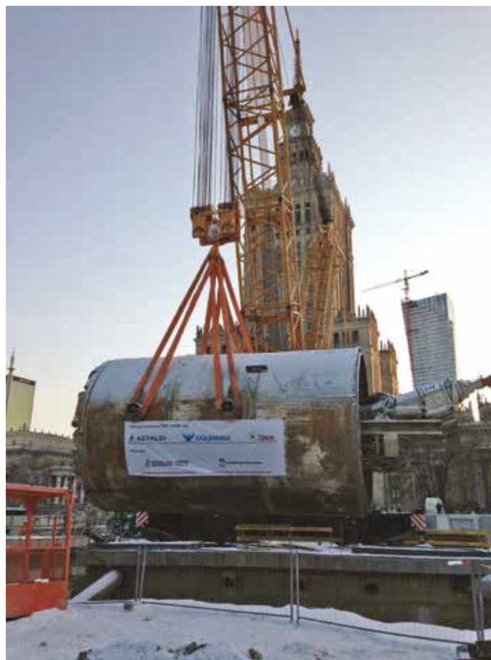
1. Il sollevamento dello scudo della TBM
