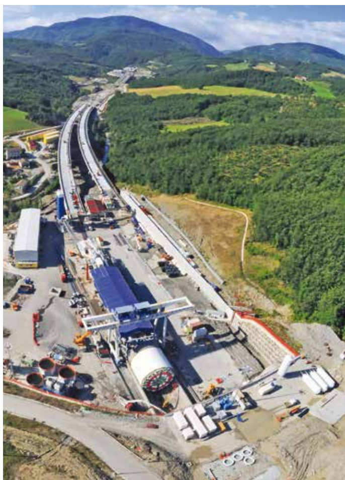
1. Veduta aerea della TBM all'imbocco delle gallerie Sparvo
