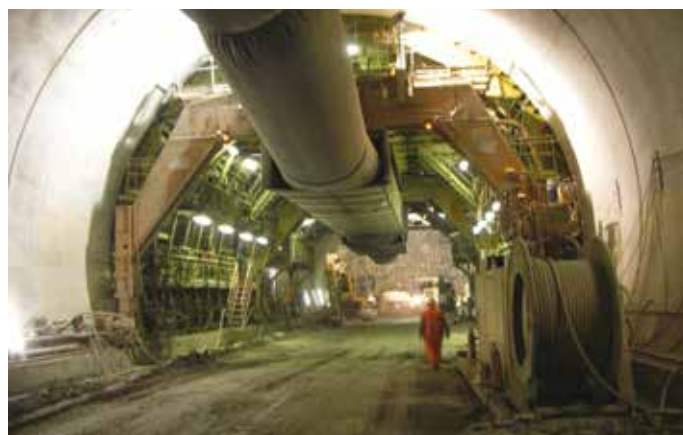
8A, 8B e 8C. Le principali fasi costruttive (ADECO)
