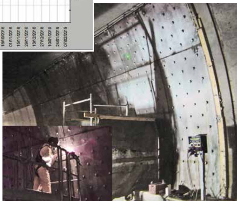
15. Il rinforzo del piedritto con piastre d'acciaio
