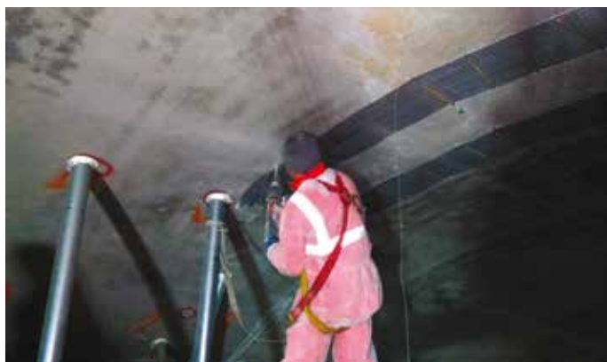
14A, 14B e 14C. L'applicazione di tessuto in acciaio UHTTS Steel Net 200
