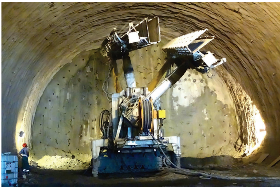
Figure 4.28 Holes drilling (Lunardi, 2008).
